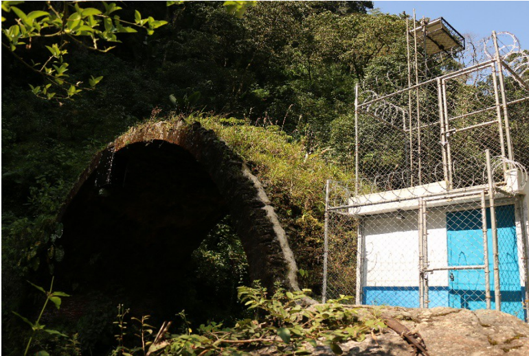
Ilustración 14: Construcción de Deselec en el cauce del río Ajajalpan
