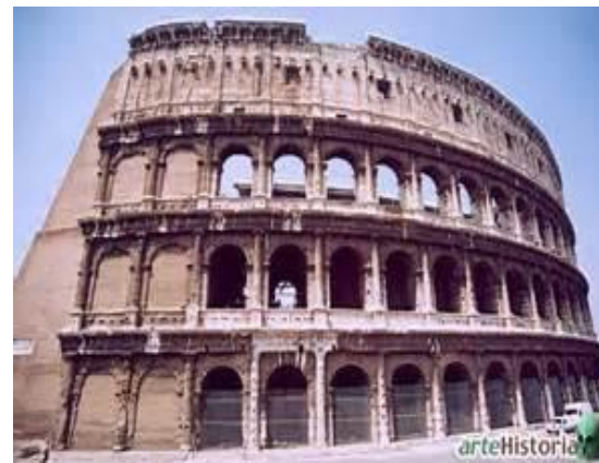
Trabajos de restauración, uso de materiales ajenos a la fábrica original
