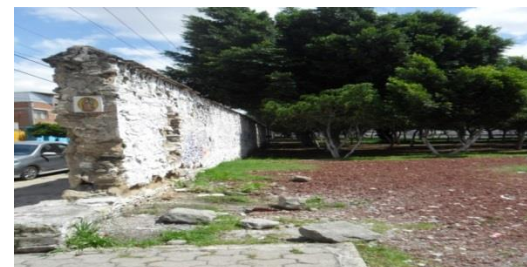
Fig. 4 Detalle de la barda traccionada para la apertura de la calle 24 norte.
