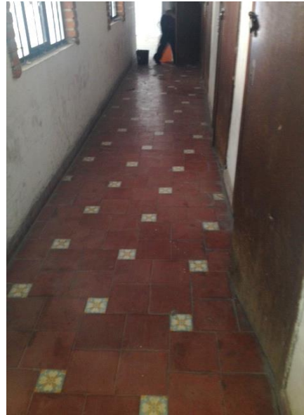
Pasillo interior hacia cuartos. Fuente: Arq. Miguel Ángel García Fernández;
