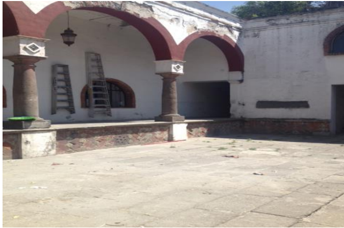
Arcadas de acceso a pasillos y primer patio. Fuente: Arq. Miguel Ángel García Fernández; 2014.
