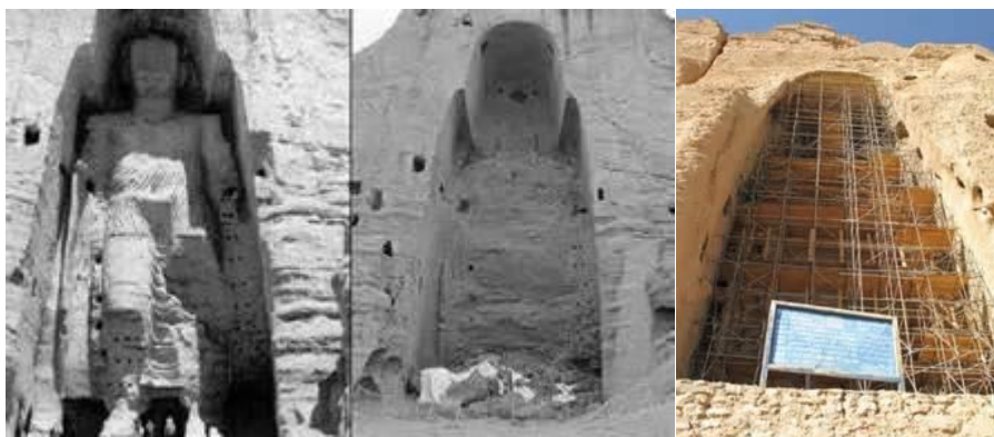
Vistas de los Budas de Bimayán. Trabajos de reconstrucción
