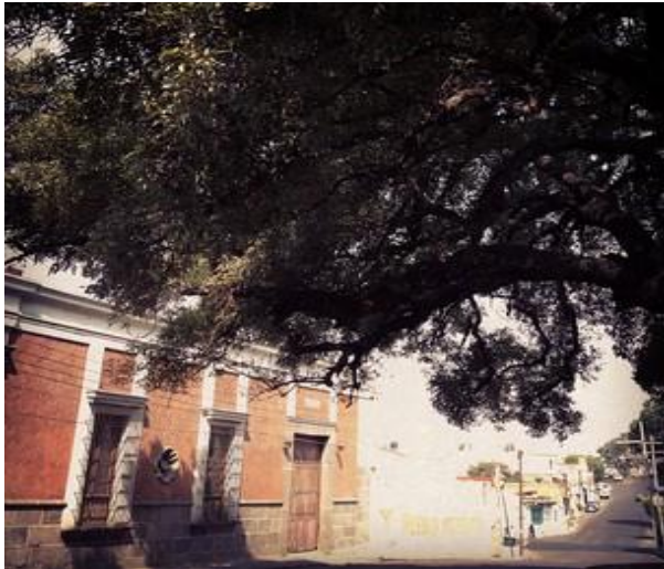
Fachada de la casa de campo. Fuente: María Teresa Rosas Yáñez: 2013.
