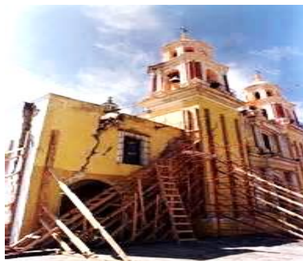
Trabajos de reconstrucción
