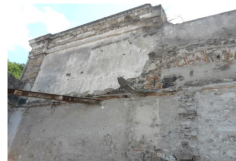
Fig. 6 Materiales y vanos tapiados.
