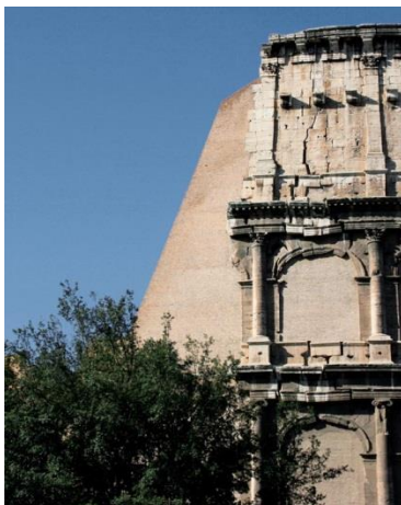
Reconstrucción de las arcadas. Segunda intervención
