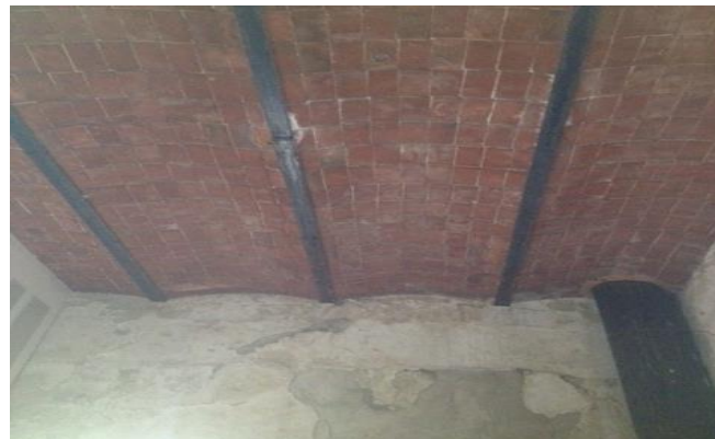
Bóveda Catalana ubicada en la cocina. Fuente: Arq. Miguel Ángel García Fernández; 2014.
