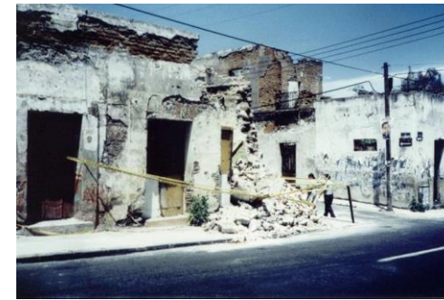
Demolición Fábrica el Mayorazgo, Puebla
