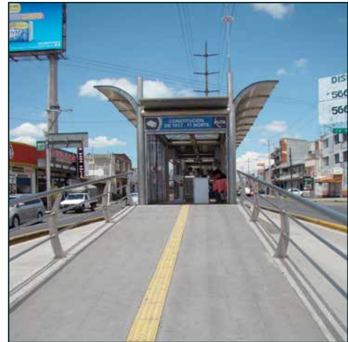
Figura 2.3. Tipología de los paraderos de la Línea 1 de RUTA Fotografía: Paradero Constitución de 1917-11 norte (Larracilla, 2014)
