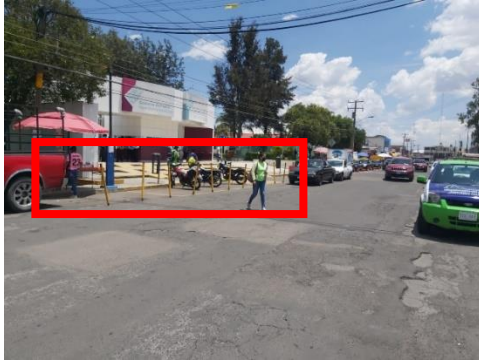
Imagen 45. Cruce peatonal sin bolardos
