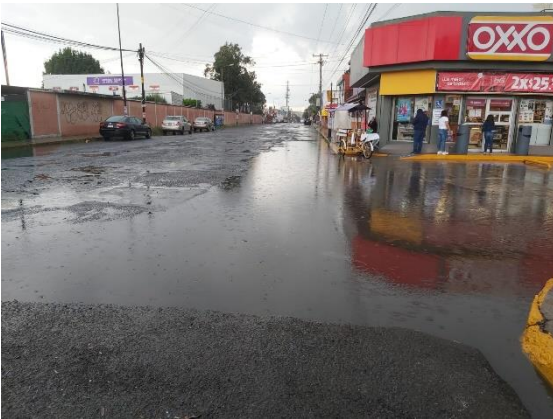
Imagen 24. Inundación sobre banqueta
