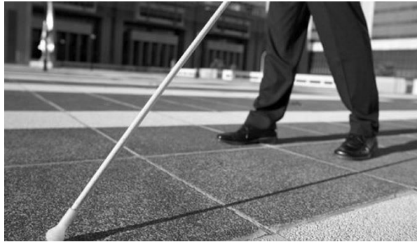
Imagen 8. Pavimentos Táctiles
