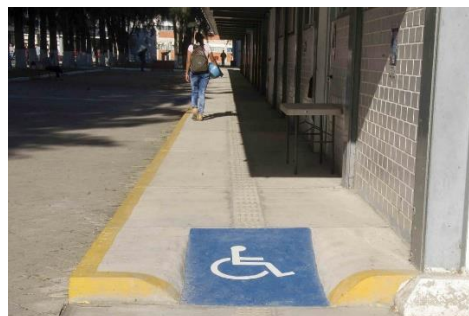
Imagen 7. Rampa para personas con discapacidad
