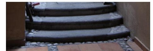
Acabado en piso de garaje. Eucalipto NO. 5 Fuente: Patlán, T. 2017
