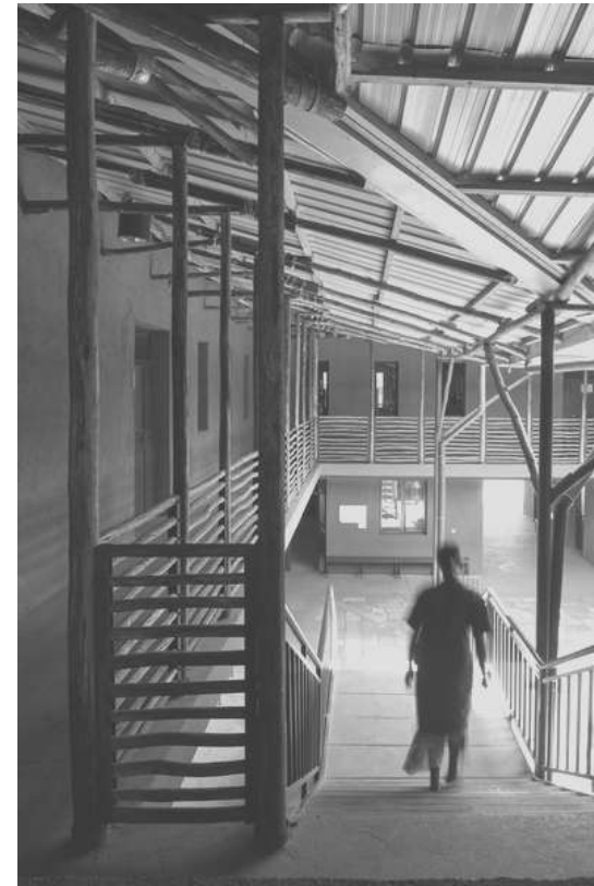
Fotografía: Campus Basajo, Sodo Etiopía. Recuperada de: https://www.archdaily.mx/mx/964651/campus-busajo-studiobenaim/60dcc77ff91c81fab600001c-busajo-campus-studiobenaim-photo?next_project=no
