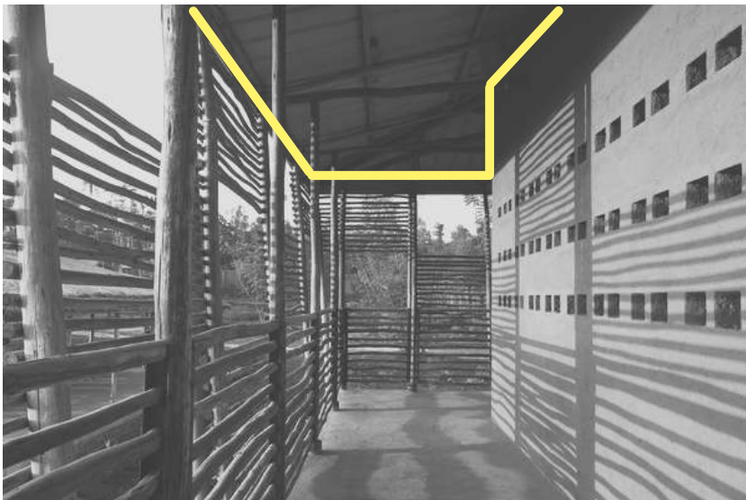
Fotografía: Campus Basajo, Sodo Etiopía. Recuperada de: https://www.archdaily.mx/mx/964651/campus-busajo-studiobenaim/60dcc77ff91c81fab600001c-busajo-campus-studiobenaim-photo?next_project=no
