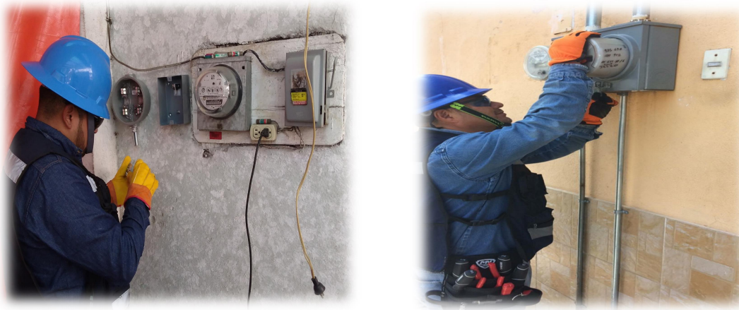
Fotografía 1.1- Cambio de medidor anterior a tipo AMI
