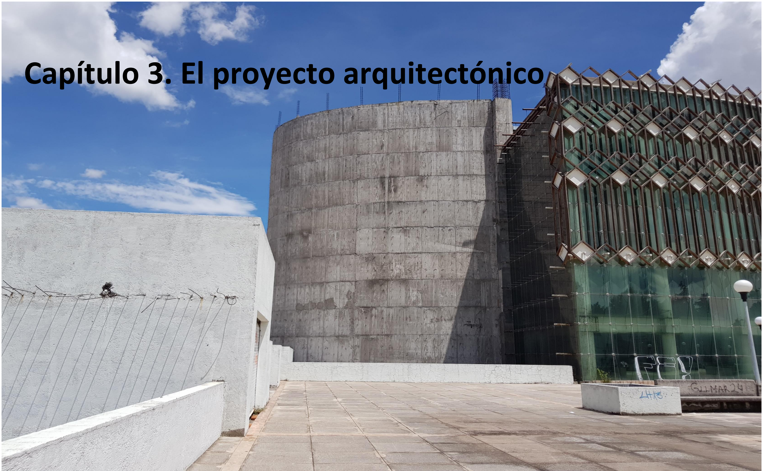
Figura 77. De autor (2018). Fachada lateral de la Plaza
