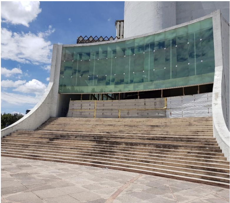
Figura 5. De autor (2018). Fachada principal de la Plaza Bicentenario.
