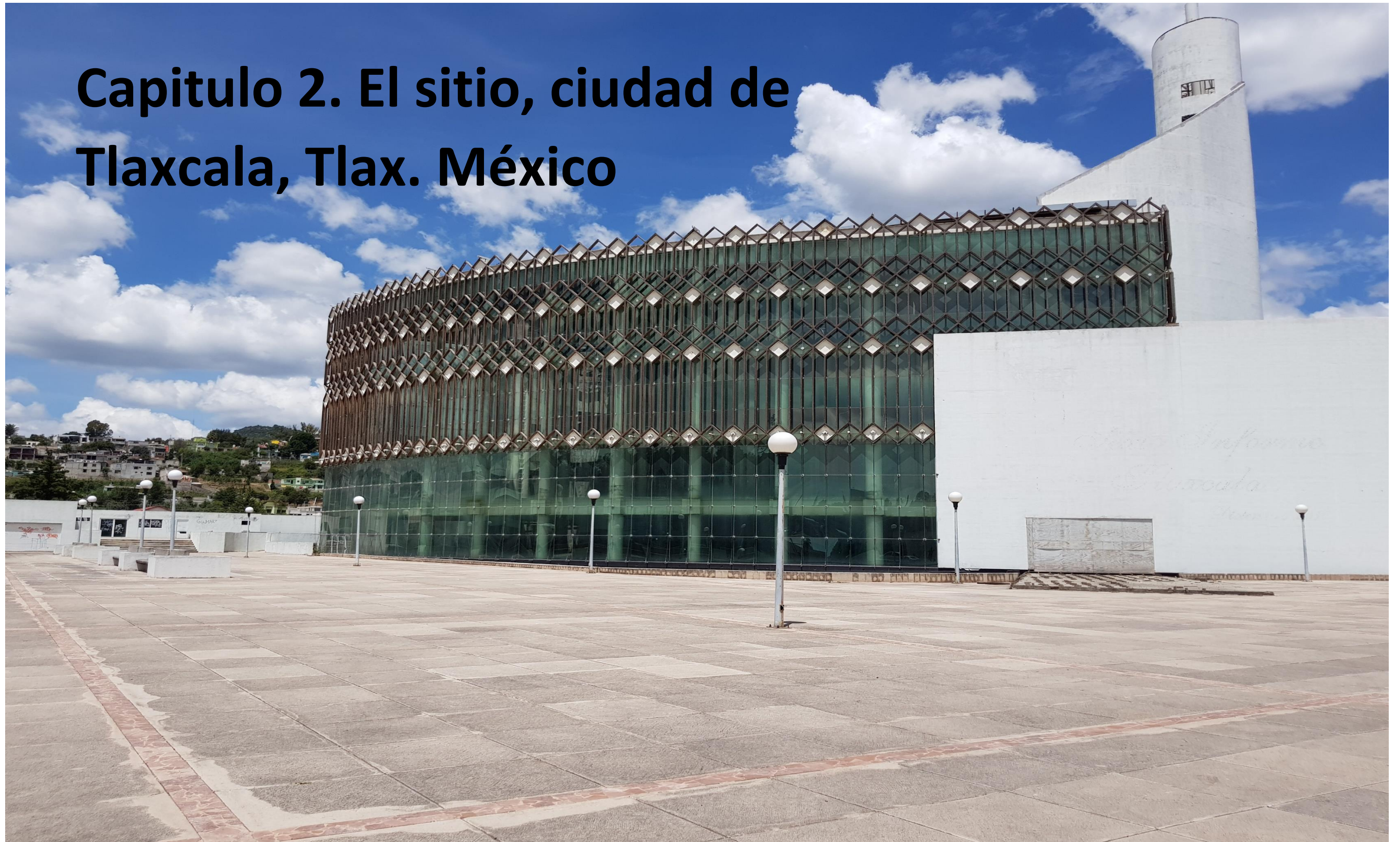
Figura 57. De autor (2018). Fachada Principal de la Plaza Bicentenario
