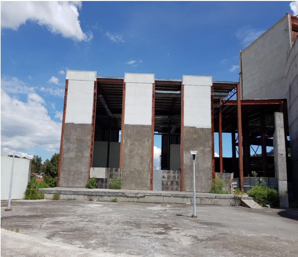
Figura 7. De autor (2018). Fachada principal de la Plaza Bicentenario.
