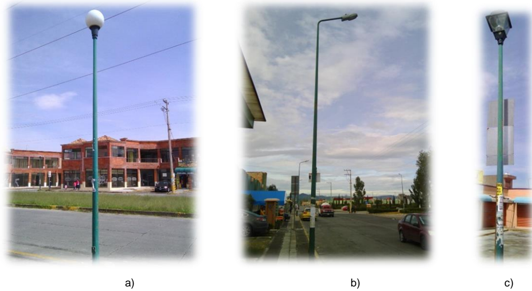
Fig. 3.20. Representación de los tipos de luminarias con los que cuenta el fraccionamiento. a). Luminaria de globo. b).Luminaria tipo. c). Luminaria de campana. Fuente: Equipo tesis
