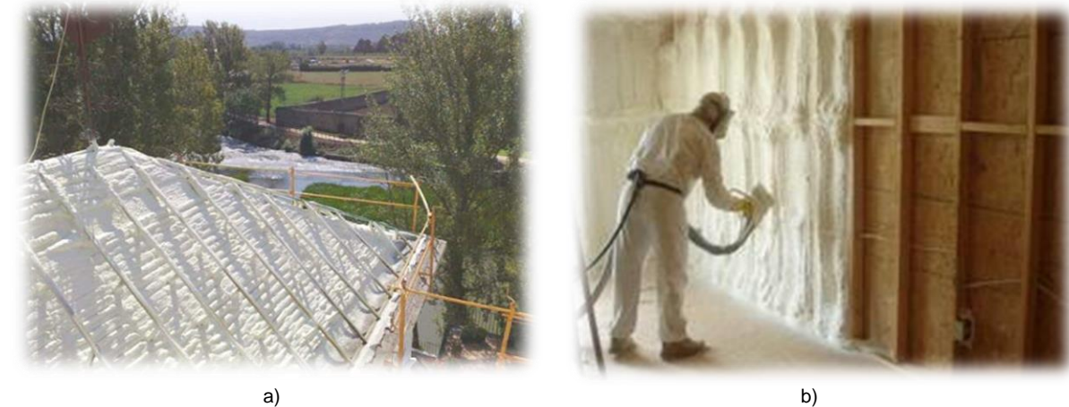
Fig. 2.6. Se muestra la aplicación de espuma sintética tanto en interior como exterior. a) Aplicación de espuma sintética al exterior del techo. b) Aplicación de espuma sintética en muros interiores. Fuente: http://www.multireformes.com/servicios_poliuretano.htm
