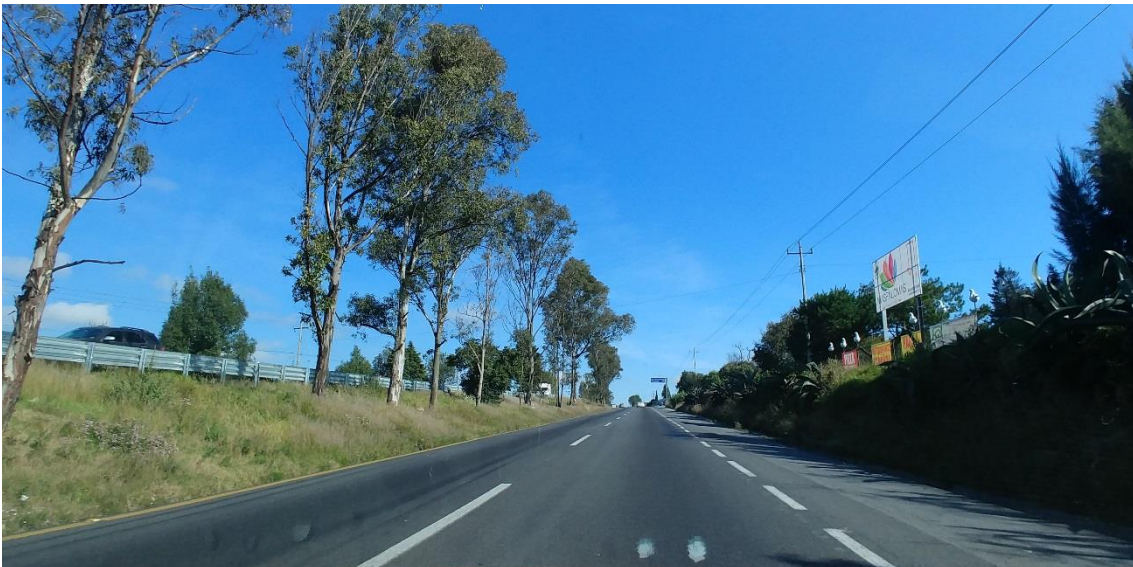
Imagen 2: Marcas en pavimento por alcance vehicular
