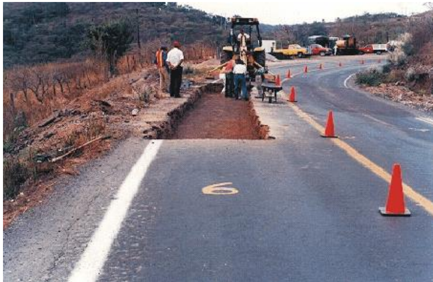
Figura 5: Trabajos de Conservación de Carreteras
