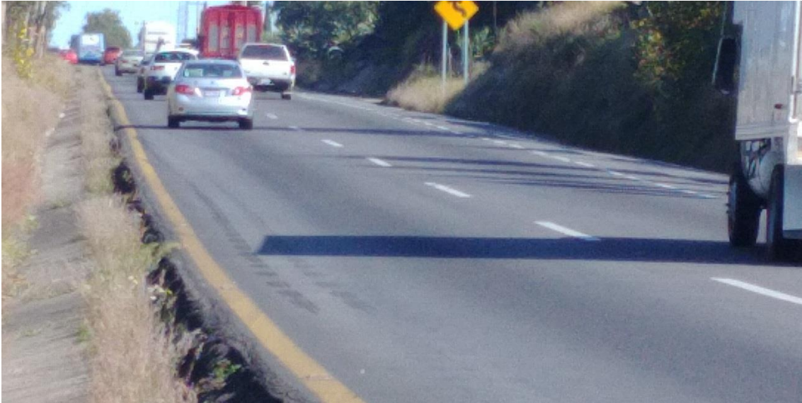
Imagen 1: Marcas en pavimento por alcance vehicular
