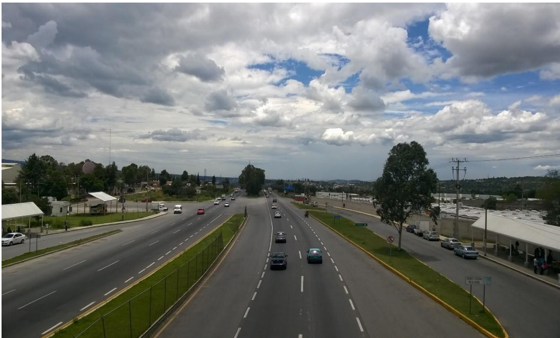
Imagen 22: Vista de Norte a Sur del Punto de conflicto en estudio, donde se observa que existen dos carriles de circulación, camellón central, zona de paradores.
