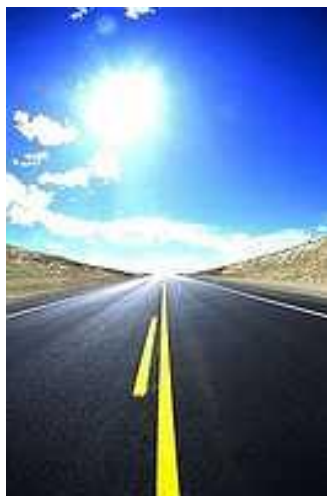
Figura 6: Trabajos de Conservación de Carreteras
