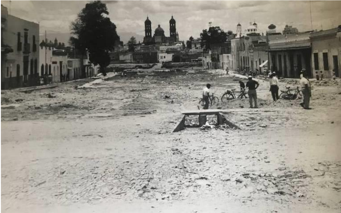
Imagen 1. “Aspecto de la 3 Oriente, cuando fue derribado el mercado Carmen Serdán y se iniciaron las obras de entubamiento del río San Francisco. Foto: Archivo” (Reyes, 2021). Consultado en: El Sol de Puebla.
