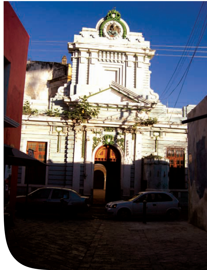
► Fig. 56 Fachada del Ex convento del carmen
