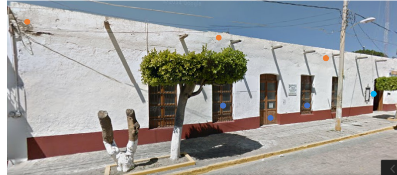
Fachada (estado actual)
