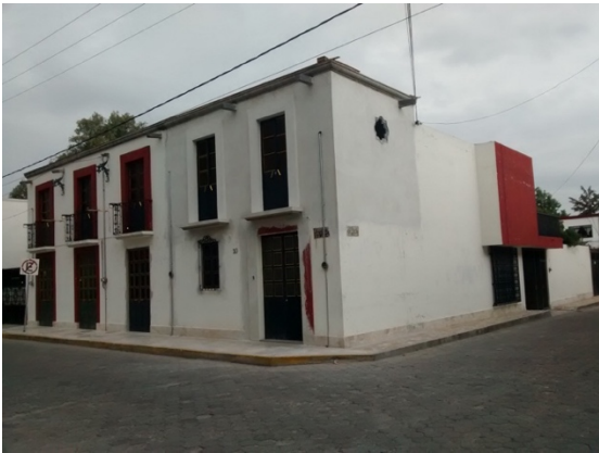
Ilustración 24. Vista noroeste. Esquina Calle 2 Norte y Av. Rafael Cortes Poniente.
