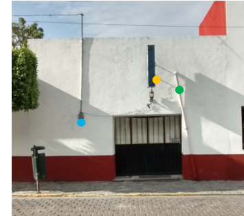
Fachada (estado actual)
