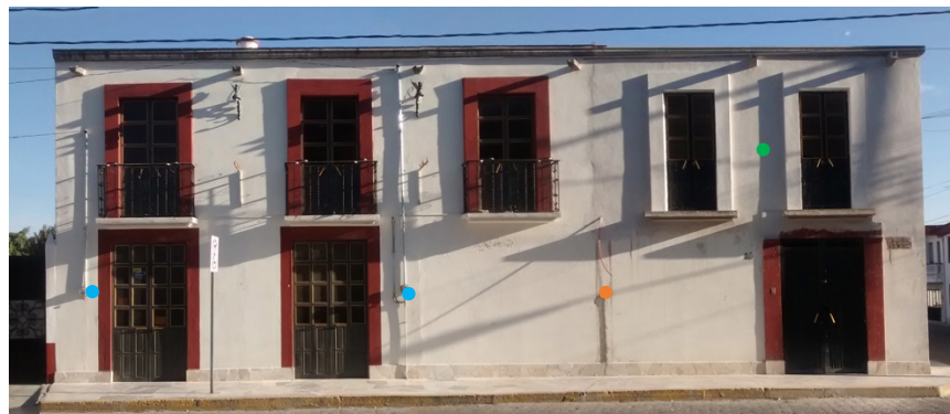
Fachada (estado actual)
