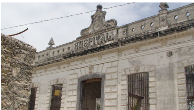
Ilustración 41. Fachada del edificio que funcionaria de Hospital.
