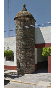
Fachada (estado actual)
