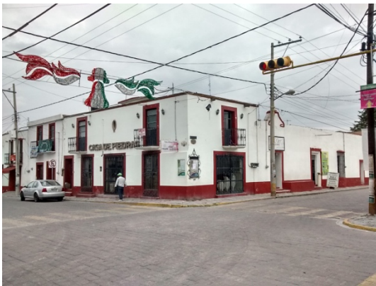
Ilustración 19. Vista noroeste. Esquina Av. 25 de Agosto y Av. Rafael Cortes Poniente.
