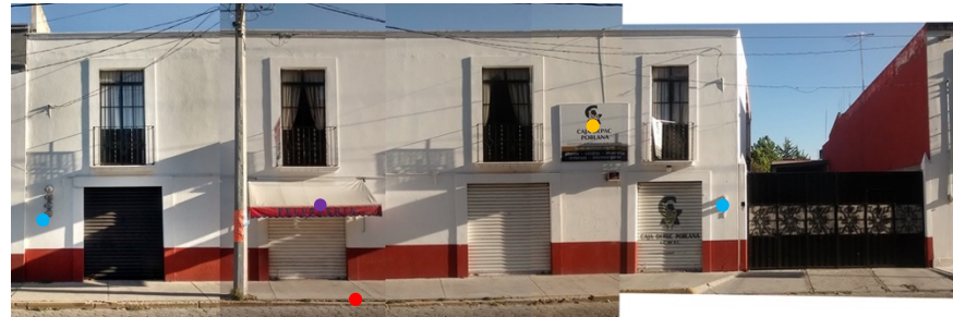
Fachada (estado actual)
