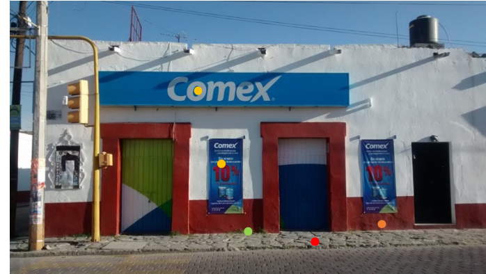
Fachada (estado actual)
