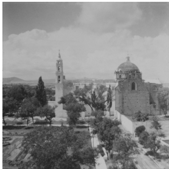
Ilustración 46. Panorámica de la iglesia y el parque. Año: 1966. Fotografía: Guillermo Soto Cortés.
