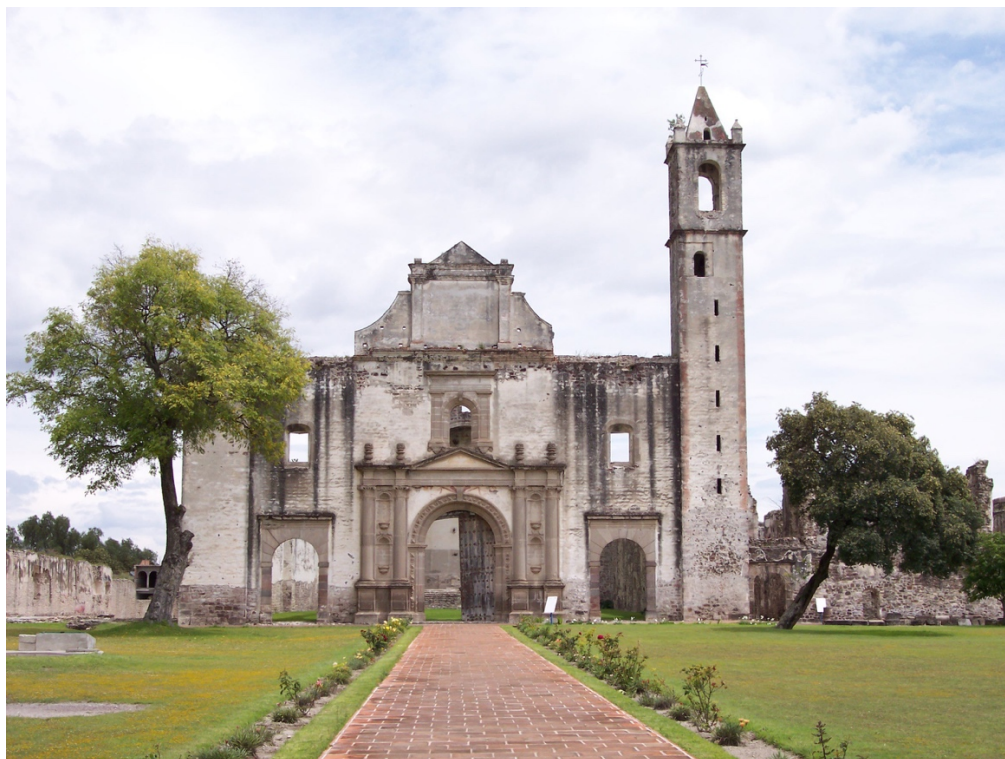
Ilustración 38. Fachada principal de ex convento Franciscano del siglo XVI de Tecali de Herrera
