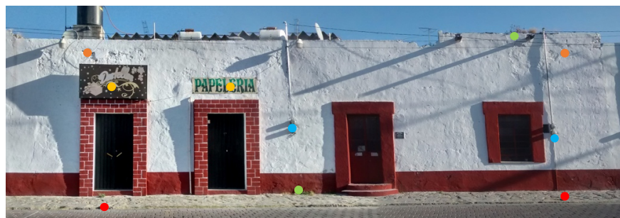
Fachada (estado actual)
