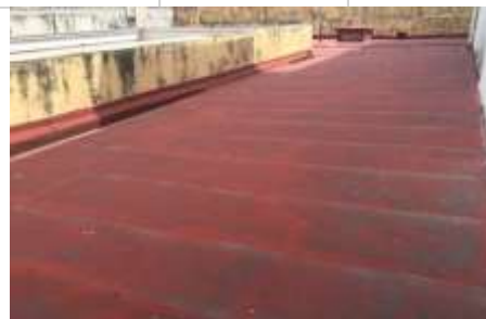
Acabado en azoteas
