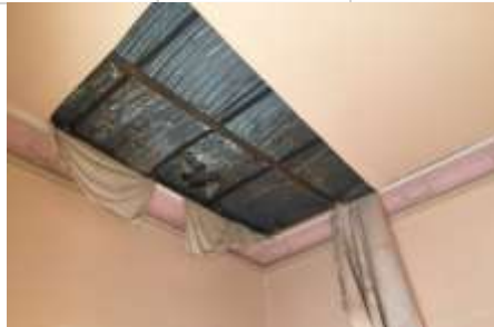
Vista de sistema constructivo en techos
