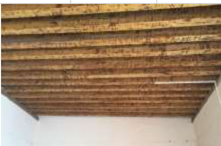
Sistema de vigería de madera
