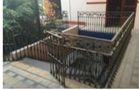
Detalle de barandal en escalera
