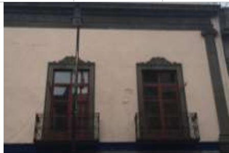
Detalle de fachada principal superior
