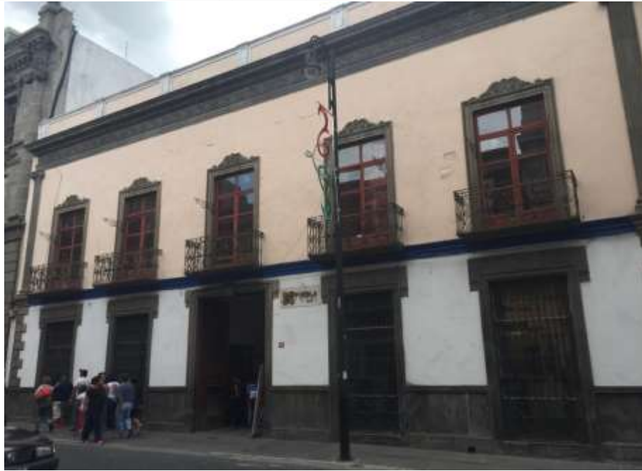
FACHADA PRINCIPAL DEL INMUEBLE
