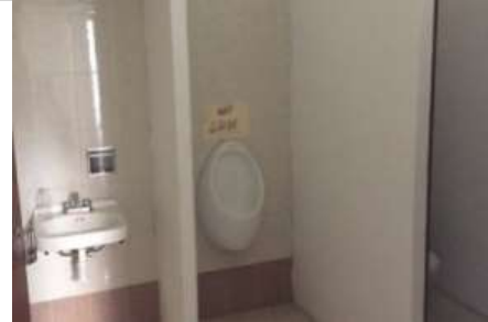
Muebles en módulo de sanitarios (P. Baja)
