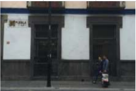
Detalle de fachada principal inferior
