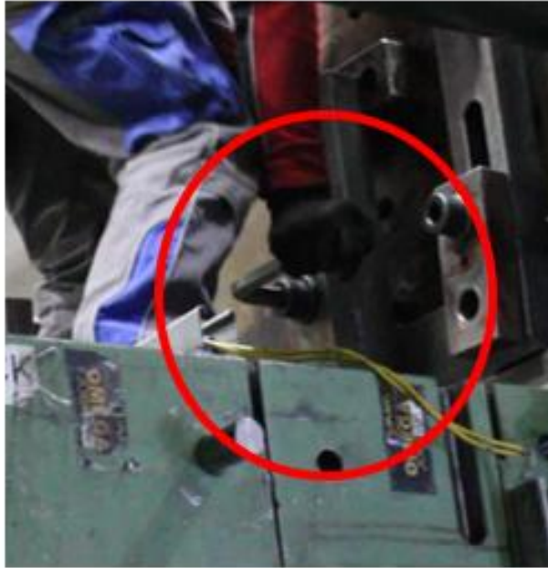
Ilustración 19 Bridas colocadas manualmente
