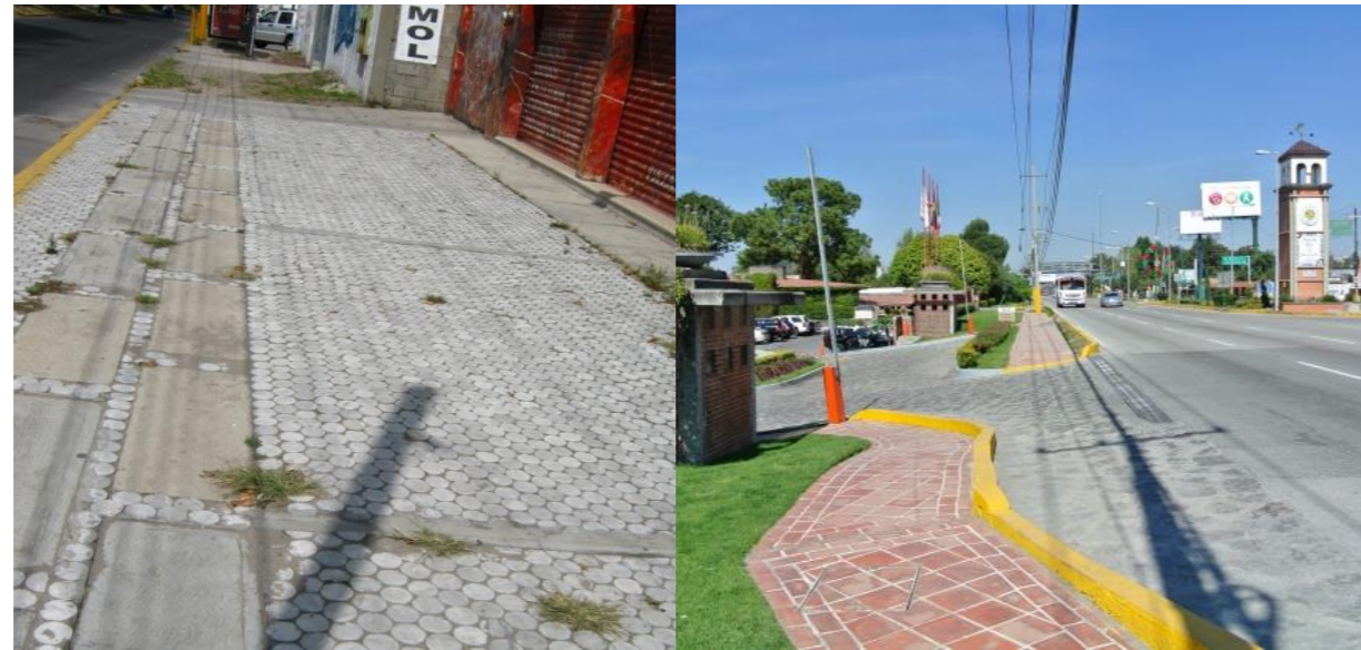
Ilustración 27 Diferentes tipos de material utilizado para las aceras. Fotografías propias tomadas en sitio.
