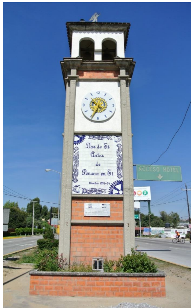
Ilustración 44 Torre del reloj en el boulevard Hermanos Serdán. Fotografía propia tomada en sitio.
