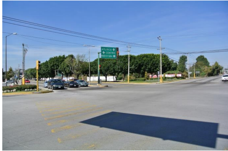
Ilustración 42 Nodo en el boulevard Hermanos Serdán cruce con Avenida Francisco Villa. Fotografía propia tomada en sitio.
