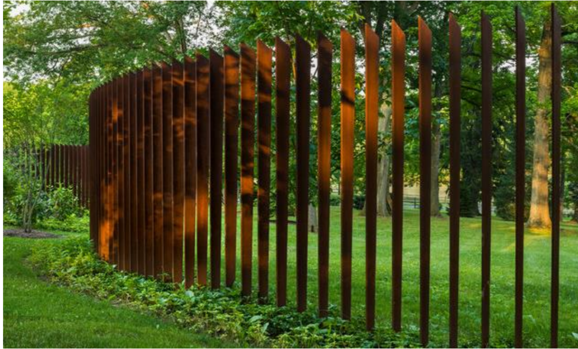
Figura 3: Diseño de la valla metálica, se aprecia su color natural que no necesita pintura y no se oxida.
