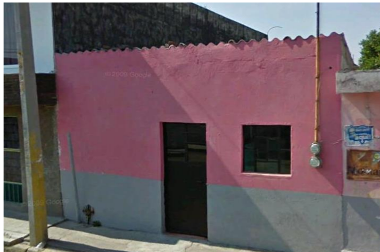
Ilustración 11 Vivienda tipo popular. Fotografía propia tomada en sitio.
