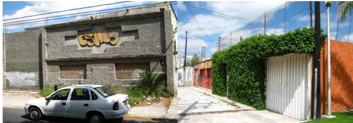
Ilustración 28 Diferente tipo de materiales usados para las edificaciones debido a la falta de una normativa. Fotografías propias tomadas en sitio.
