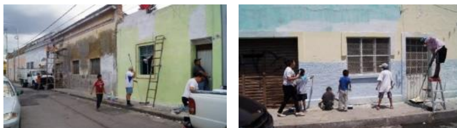
Imágenes 72 y 73. Trabajo conjunto entre vecinos, universitarios, voluntarios y personal del ayuntamiento de Puebla para la pintura de fachadas. (RGE)
