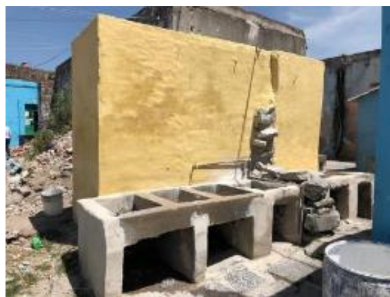
Imagen 142. Módulo de baños y lavaderos colectivos después de la intervención, julio 2018. (RGE)
