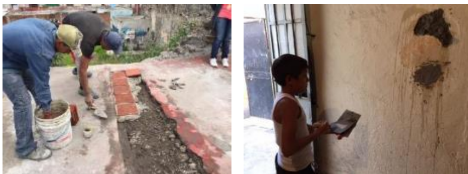
Imágenes 77 y 78. Talleres de mantenimiento en azoteas y repellados en muros, junio 2015. (RGE)
