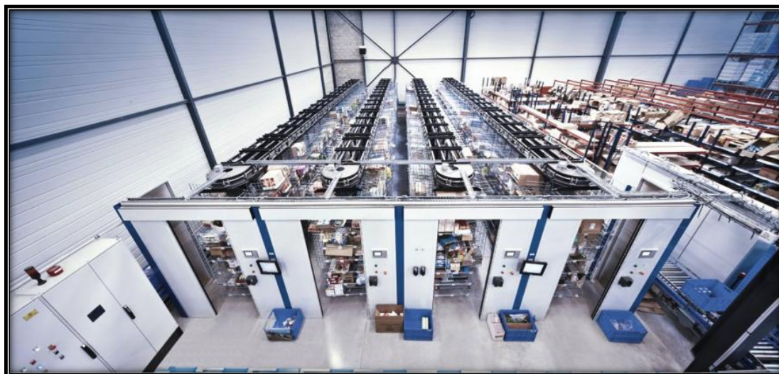
Figura 10. Sistema de almacenamiento por carrusel. Nota. Tomado de Carrusel horizontal: cómo puede mejorar tus procesos de almacenamiento automático y surtido, GIEICOM, 2025.
