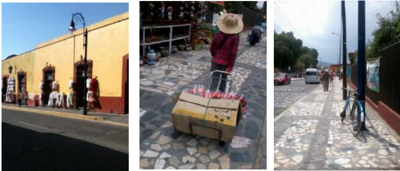
Estado actual del corredor turístico sobre Av. Morelos. Fotografías: Aguilar González, Verónica (2013)
