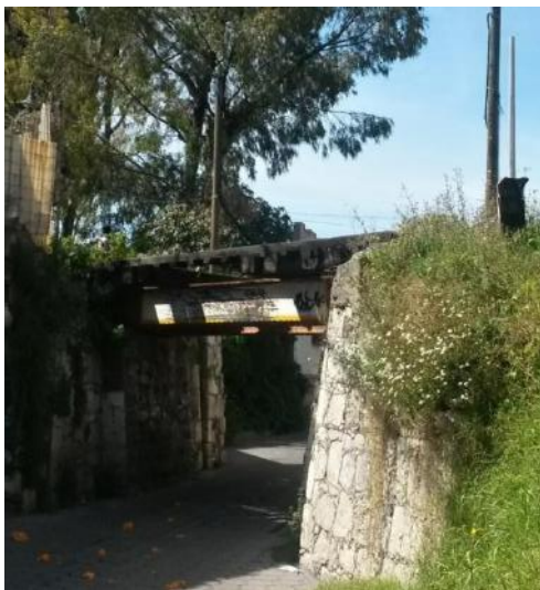
Estado actual del puente ferroviario ubicado en la intersección del sendero con la 2 oriente. Fotografía por Aguilar González, Verónica. 2014
