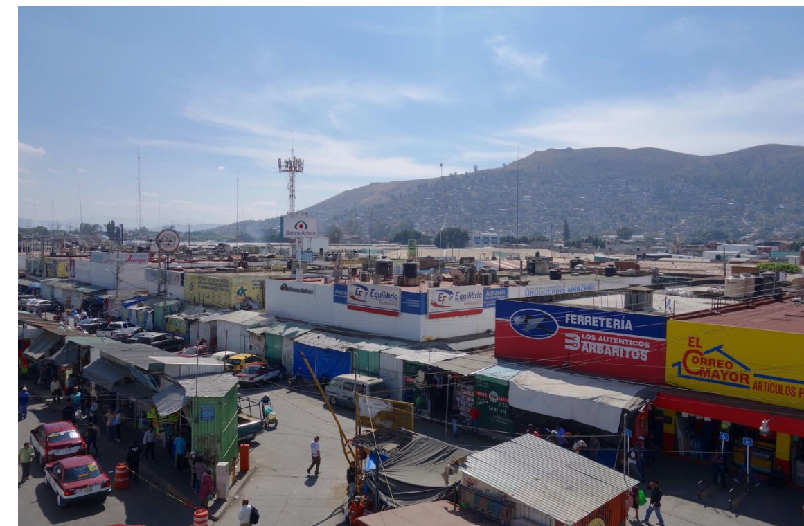
Locales y vialidad aledaña de la Central de Abastos Foto: Dominio Público Figura 14
