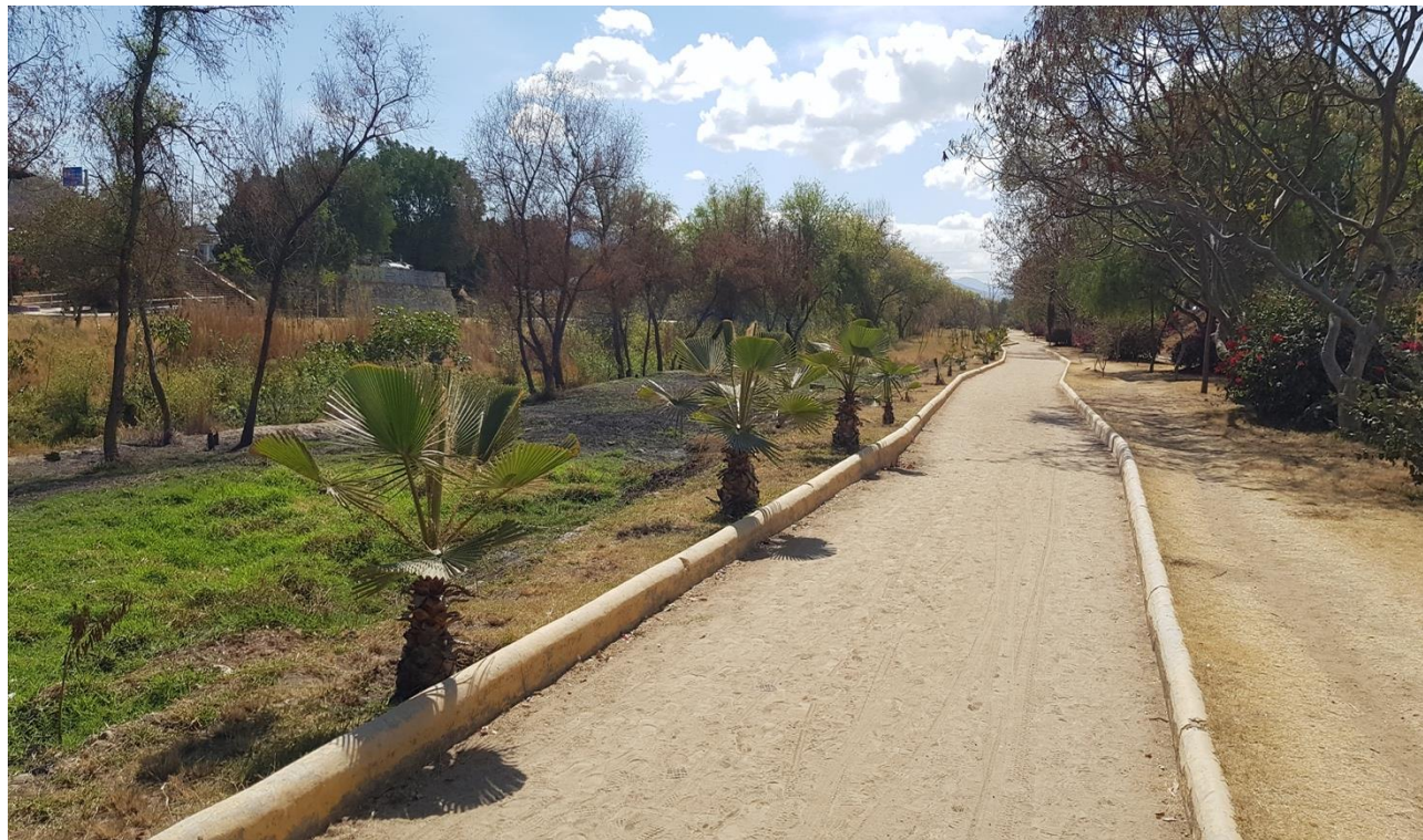
A cierta altura del Parque Lineal, tanto el sendero para caminar como la ciclovia se unen en un solo camino Imagen: Autoría Propia Figura 56
