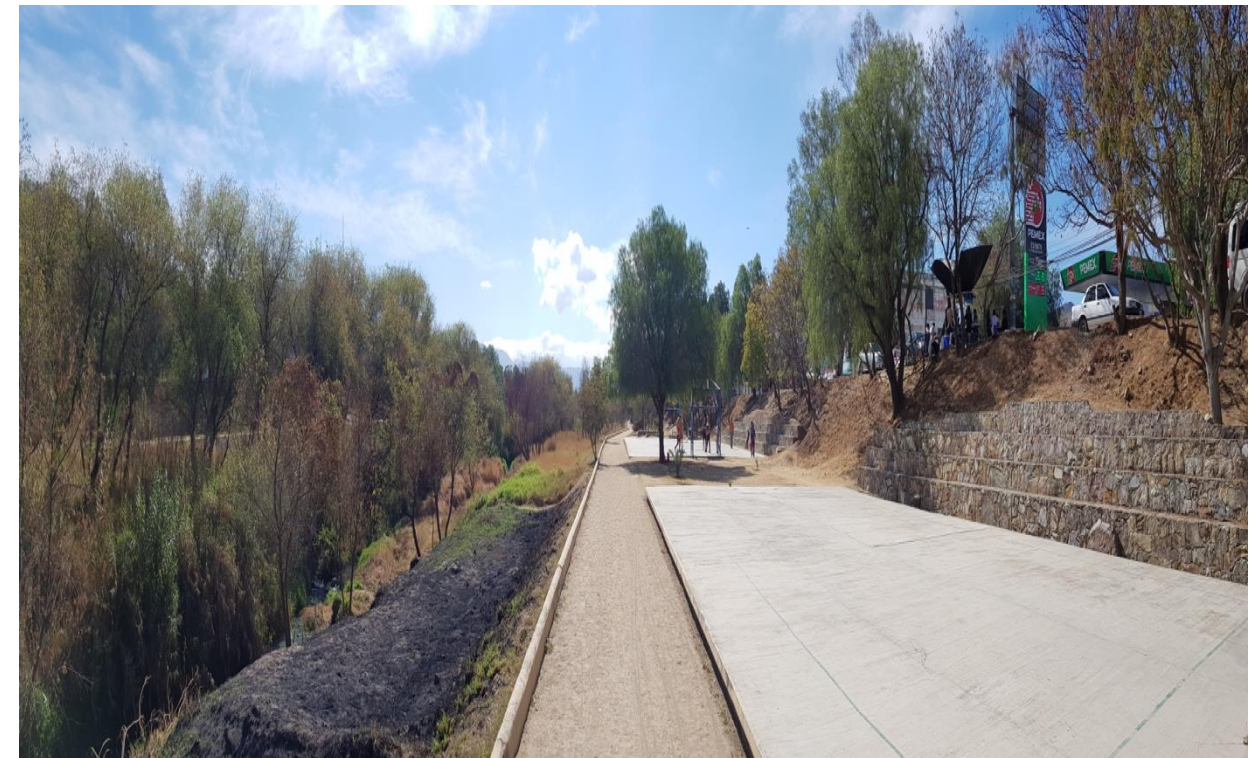
Estado actual de las canchas y ciclovía del Parque Lineal Foto: Autoría Propia Figura 17
