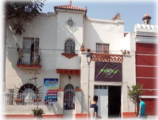
FIG.53 Fotografía desde el Jardín del Carmen hacia la 17 Oriente, vista de un edificio de estilo neo-californiano. Fuente: Fotografías tomadas por Arq. Pablo de Jesús Ruíz López (2016).
