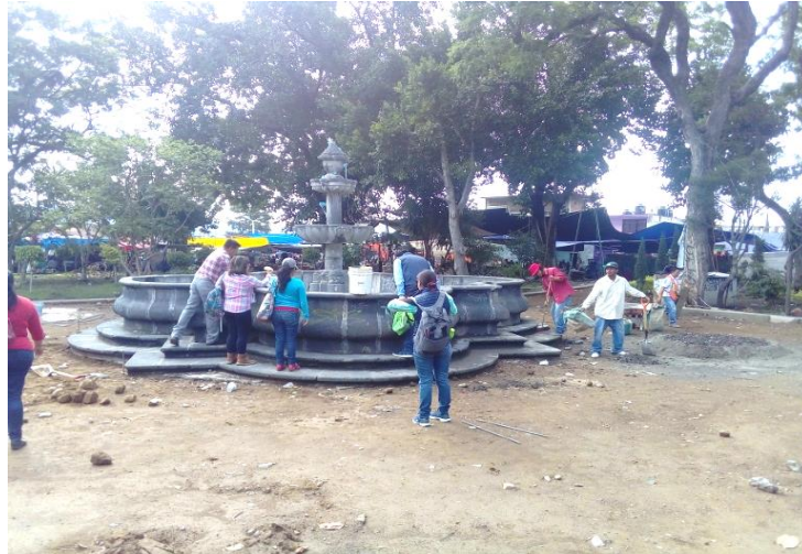
FIG.5 Mantenimiento del Parque Álvaro Obregón, Atlixco, Puebla. Fotografía: Arq. Pablo de Jesús Ruíz López (2017)
