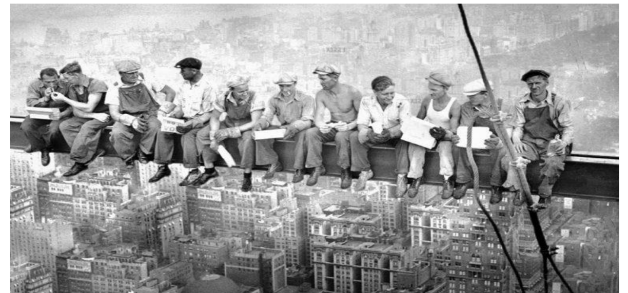
Nota: Trabajadores en la parte más alta de la construcción de una torre, Reproducida de Almuerzo sobre un rascacielos, 1932 ( https://es.wikipedia.org/wiki/Lunch_atop_a_Skyscraper#/media/Archivo:Lunch_atop_a_Skyscraper.jpg ) Dominio Público.
