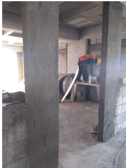
Observamos las grandes columnas y traveses que forman la unión y el marco rígido, y un muro solo divisorio.
