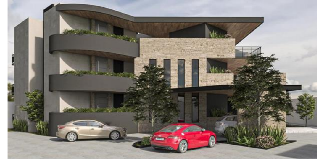
Fachada lateral Oeste
