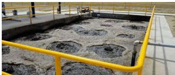
Figura 6. Fotografía de lodos activados para el tratamiento de aguas residuales, fuente: https://gruporivend.com/lodos-activados-floculacion-y-oxidacion-plantas-de-tratamiento-de-aguas-residuales/ .
