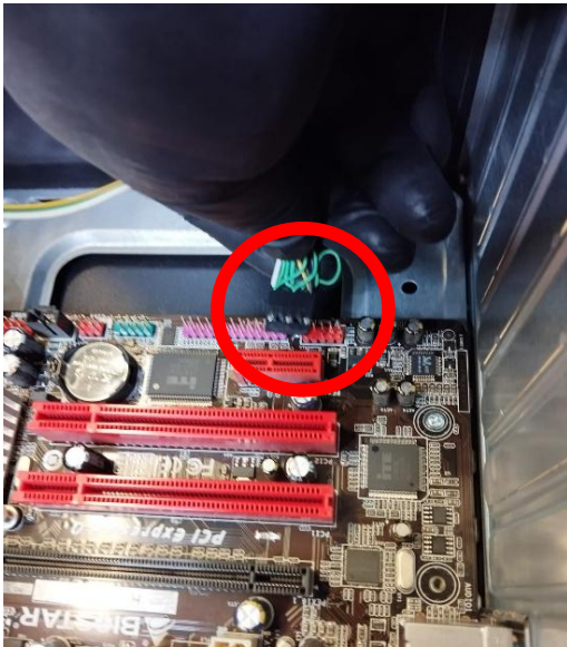
Imagen 53a. Cables frontales
