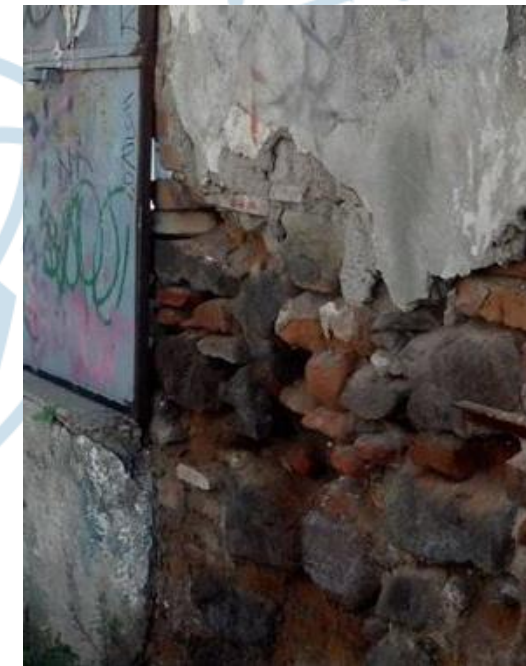
Imagen 3.7.1 Muro de Limosna.
