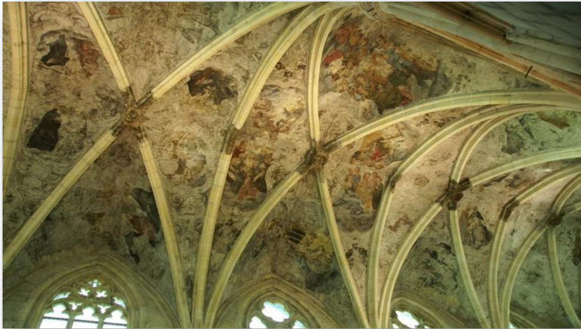
➤ Vista General de las Bóveda
