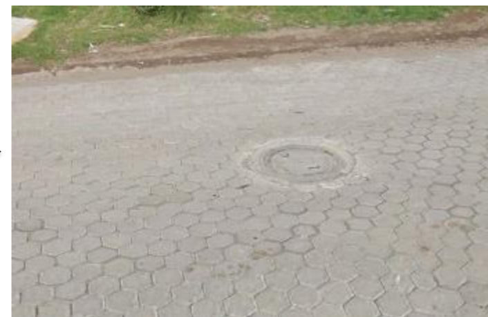
Figura 48: Drenaje Municipal ( Tomada por tesistas. 2017)
