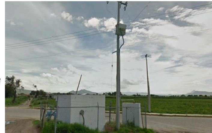
Figura 46: Pozo de agua ( Tomada por tesistas. 2017)
