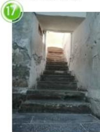
ESCALERA DE ACCESO A LAS CRIPTAS
