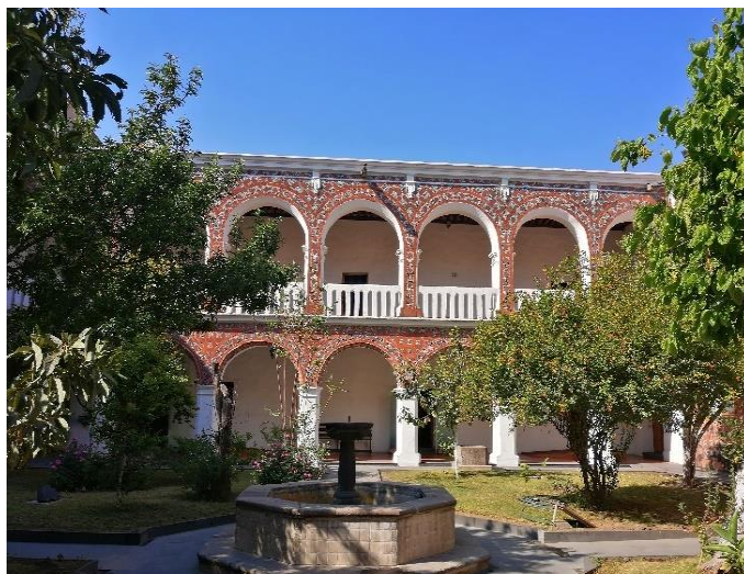
35 Fachada sur del patio de profesas. Fotografía del autor 2022
