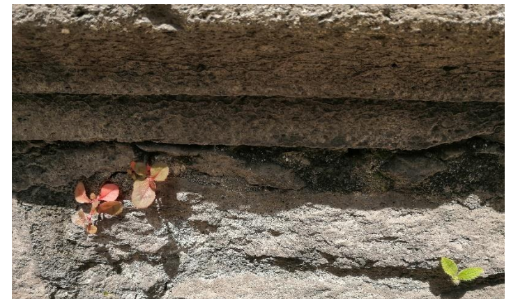
18 Presencia de flora creciendo en los morteros de junta y asiento de muro de piedra en una casa de la avenida 18 poniente en la ciudad de Puebla. Fotografía del autor 2023
