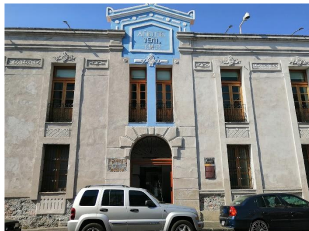
Fachada principal del exconvento de Santa Mónica. Fotografía del autor 2022
