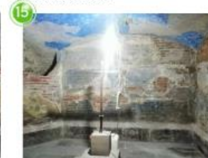
MURO SUR DE LAS CRIPTAS
