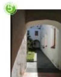
5 PASILLO REFECTORIO VISTA AL PATIO DE NOVIAS
