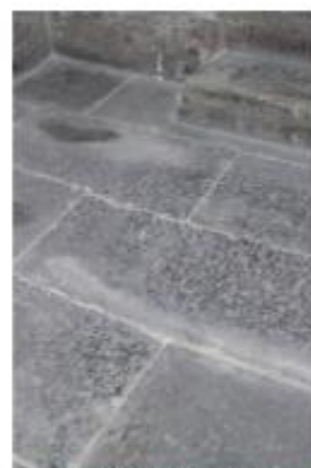
Cristalización de sales en el piso de piedra labrada
