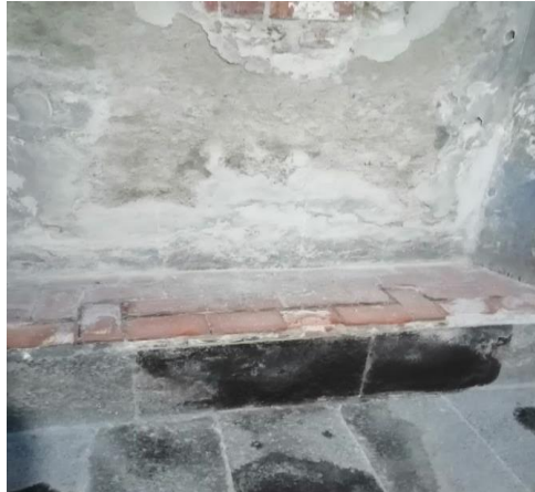
23 Banca de oración de las monjas al interior de las criptas, se observa filtración de la humedad después de la primera lluvia del año. Fotografía del autor 2022.
