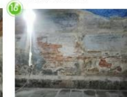
MURO OESTE DE LAS CRIPTAS
