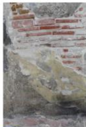
Intervención mediante colas de origen animal y pellón
