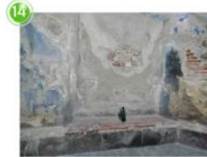
MURO ESTE DE LAS CRIPTAS
