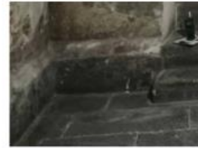
IMC66 PISO DEL INTERIOR DE LA CRIPTA EN RECINTO NEGRO CON JUNTA DE MORTERO CAL-ARENA. FOTOGRAFÍA DEL AUTOR AÑO 2022
