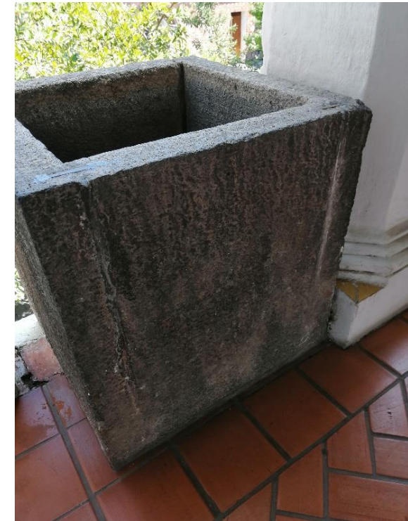
12 Notorio actuar de los elementos medioambientales en la piedra labrada de la pila para agua presente en el exconvento de Santa Mónica. Fotografía del autor 2023
