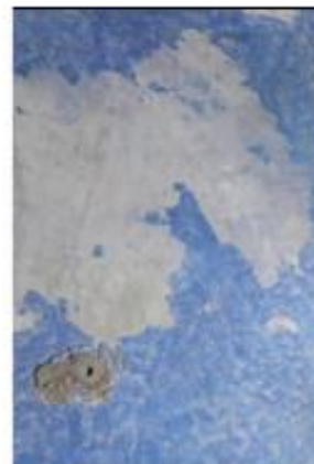
Apertura de vano para incorporar un tubo de PVC de 2"
