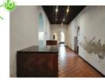
10 PASILLO DE ACCESO AL ANTECORO BAJO
