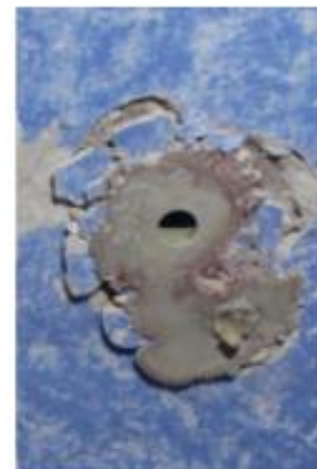
Agregado de mortero cemento arena
