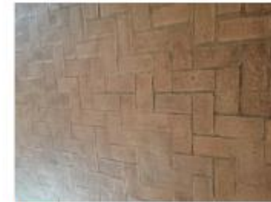
IMC61 PISO DEL INTERIOR DEL CORO BAJO SE PUEDE VER EL ACABADO POLIMÉRICO FOTOGRAFÍA DEL AUTOR AÑO 2022
