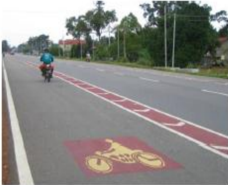
Figura 4.9. Las contramedidas especiales para motociclistas, tales como carriles separados reducen las probabilidades de que un motociclista sufra una colisión severa
