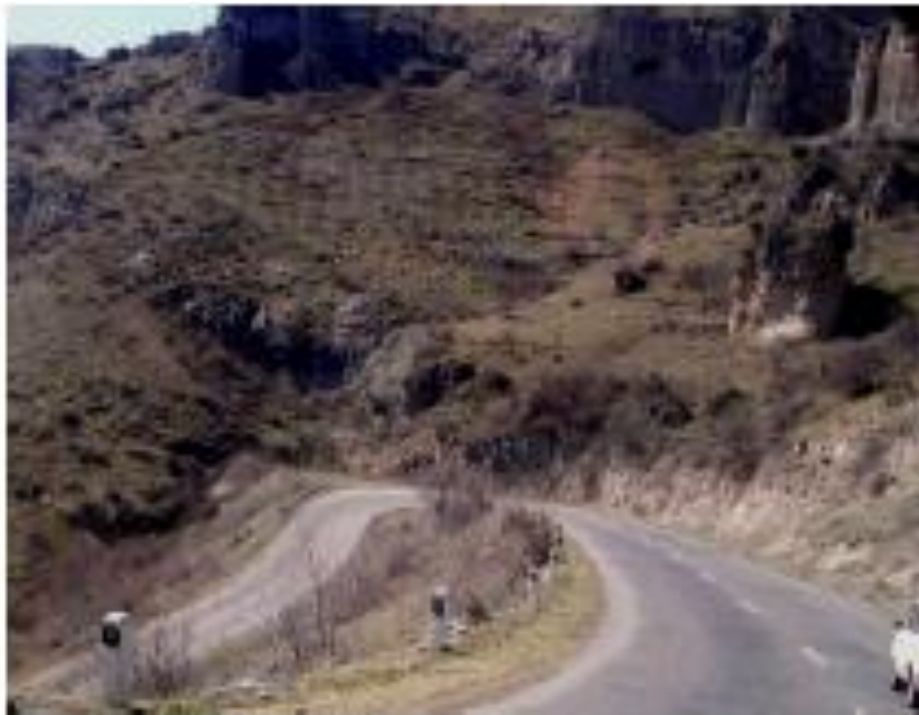
Figura 4.8. En cortes con curvas pronunciadas, pendientes fuertes y terraplenes altos el Factor de riesgo puede variar de 5 a 10.
