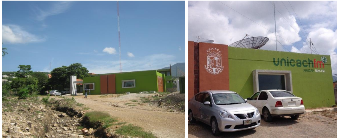
Figura 63 Detalle 3 de colores oficiales en torre y edificio terminado
