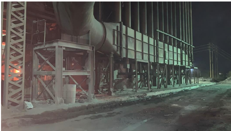
Figura 4.5 Zona frontal del edificio de acería
