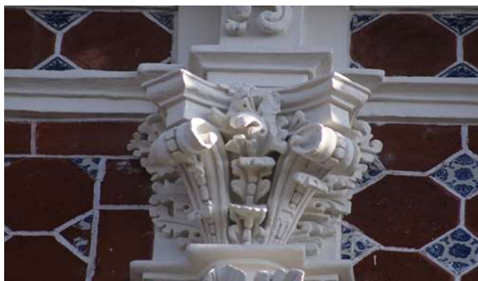
Ilustración 13. Detalle de argamasa y petatillo al exterior.
