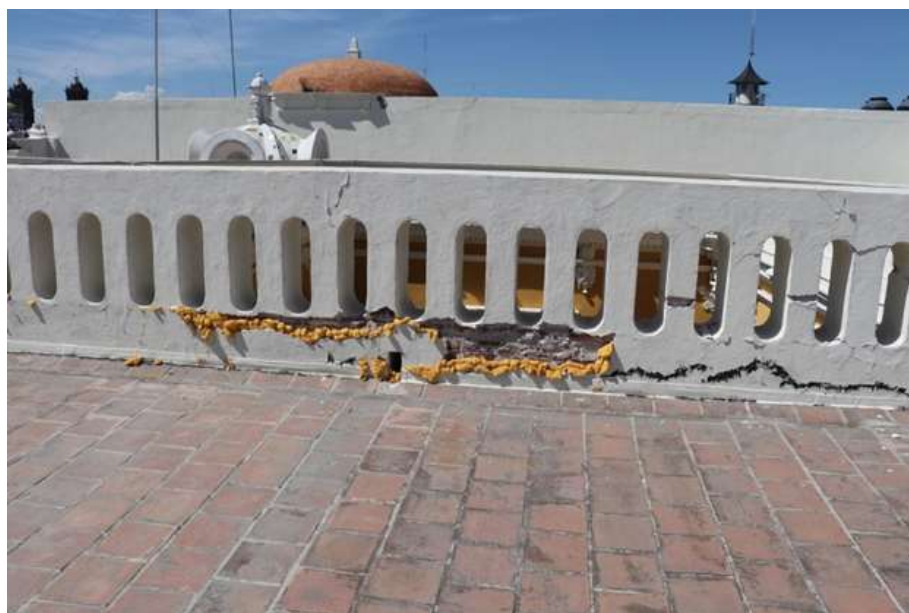
Ilustración 34. Balaustrada perimetral del patio central Sur
