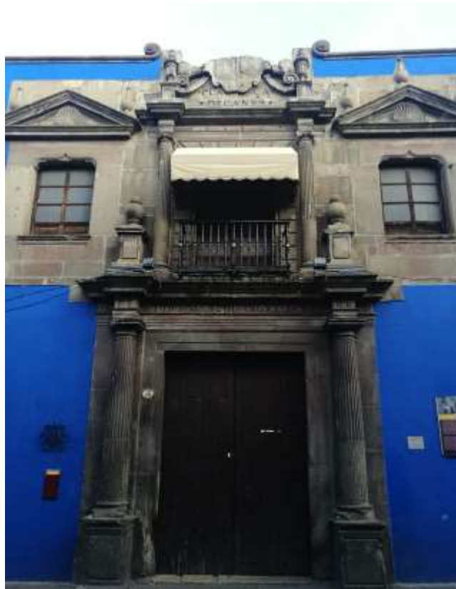
Ilustración 7. Fachada de la Casa del Deán, ubicada en la 16 de Septiembre #505
