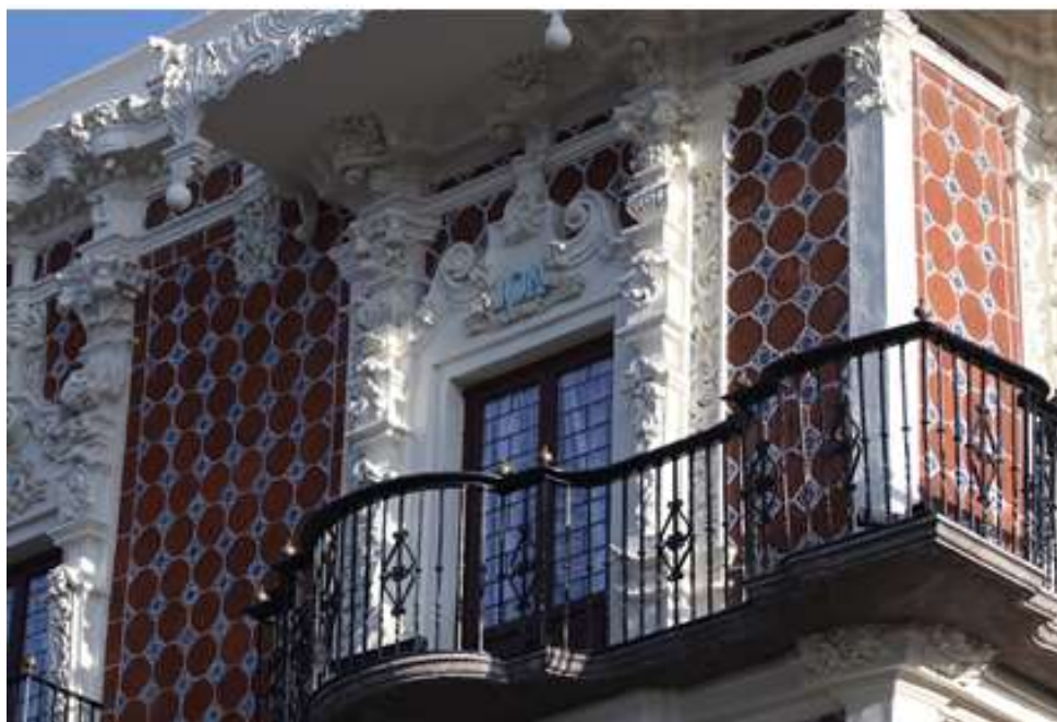
Ilustración 16. Balcones exteriores de hierro forjado.
