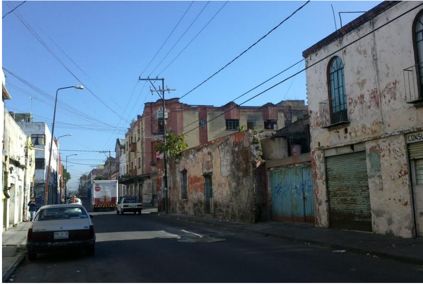
Fotografía 3. Deterioro de Viviendas entorno al Mercado 5 de Mayo, Santa Anita
