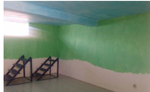
Figura 5. Paredes 2 y 3 trazadas y con la aplicación de la primer capa de pintura.
