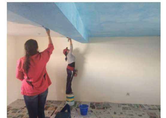
Figura 3. Pared 3 del aula del colegio. Figura 4. Paredes 4, 5 y 6 del aula del colegio.
