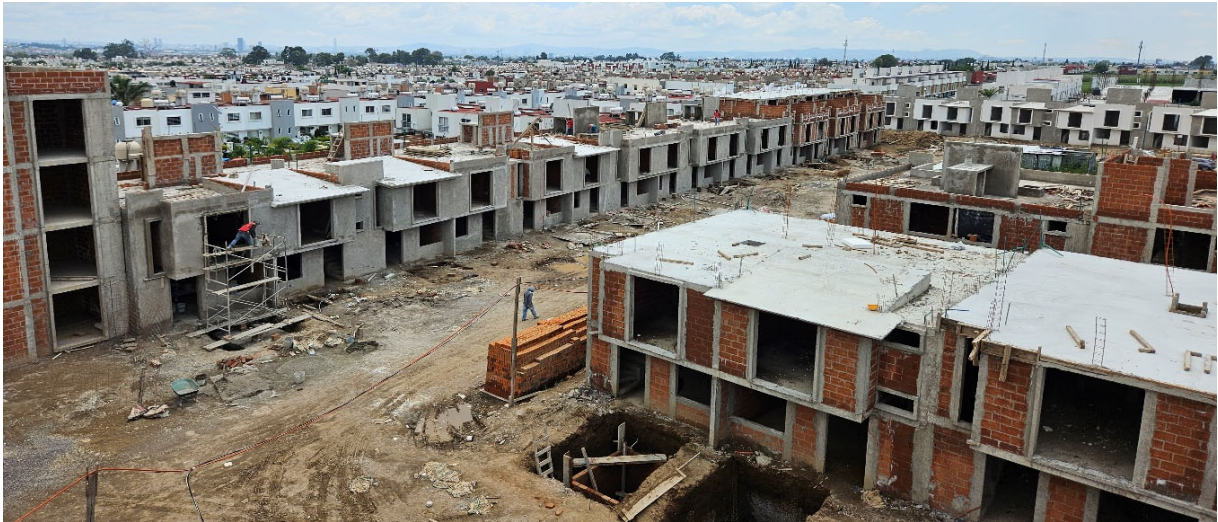
Imagen 31 Vista de la obra 2. Fuente: Propia
