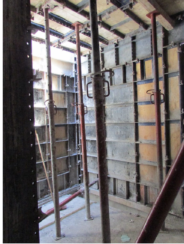
Imagen 61, Cimbra metálica para muros y losas, Empresa 4. Fuente: Propia
