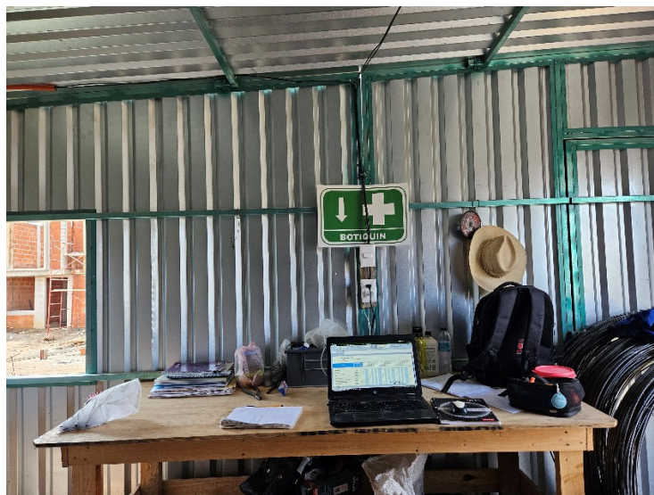
Imagen 74 Localización de botiquín de primeros auxilios en almacén de contratista, Obra 4, Empresa 2. Fuente: Propia
