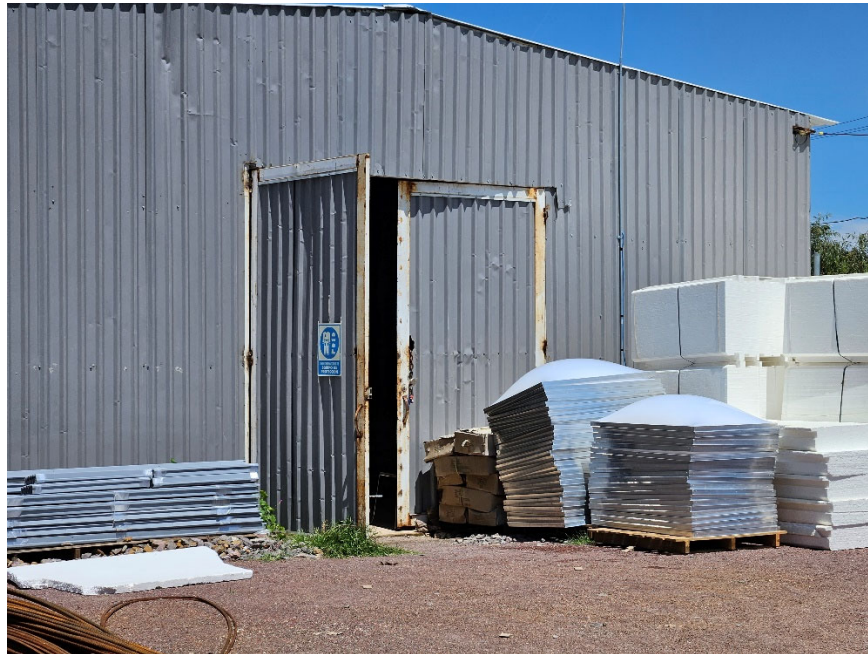
Imagen 53 Almacén de la empresa 1. Fuente: Propia
