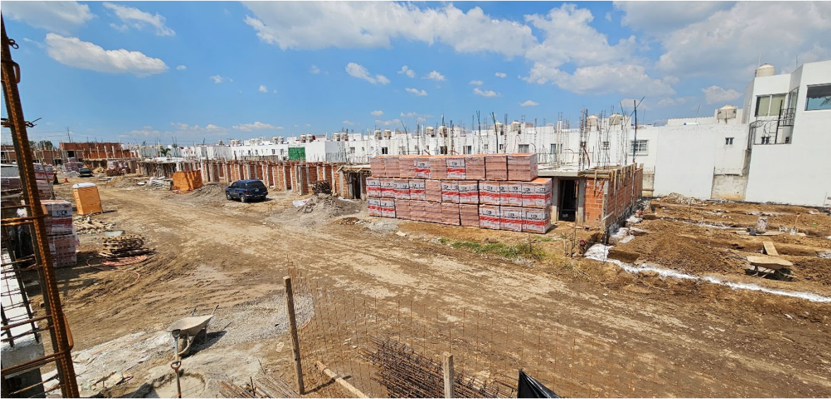
Imagen 33 Construcción de la obra 4. Fuente: Propia
