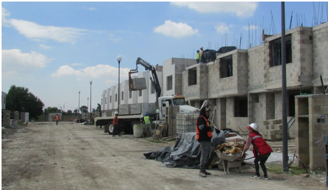
Imagen 47 Elevación de block a losa de azotea de las viviendas. Fuente: Propia.
