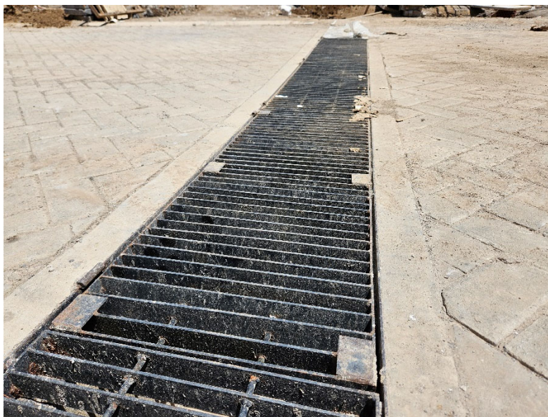
Imagen 44 Mejoramiento de la rejilla de colector pluvial. Fuente: Propia.
