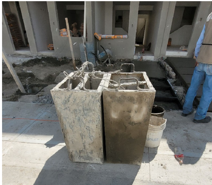
Imagen 60 Cimbra metálica para registros sanitarios, Empresa 4. Fuente: Propia
