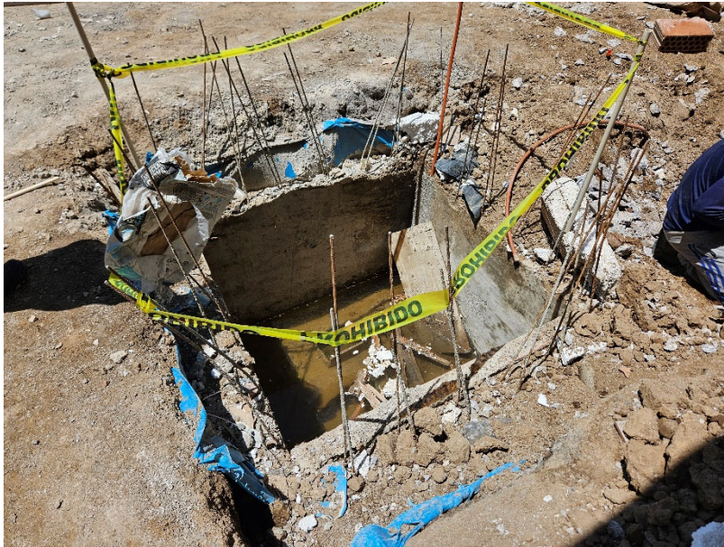
Imagen 71 Cisterna en construcción delimitada con cinta de precaución, Empresa 1, Fuente: propia
