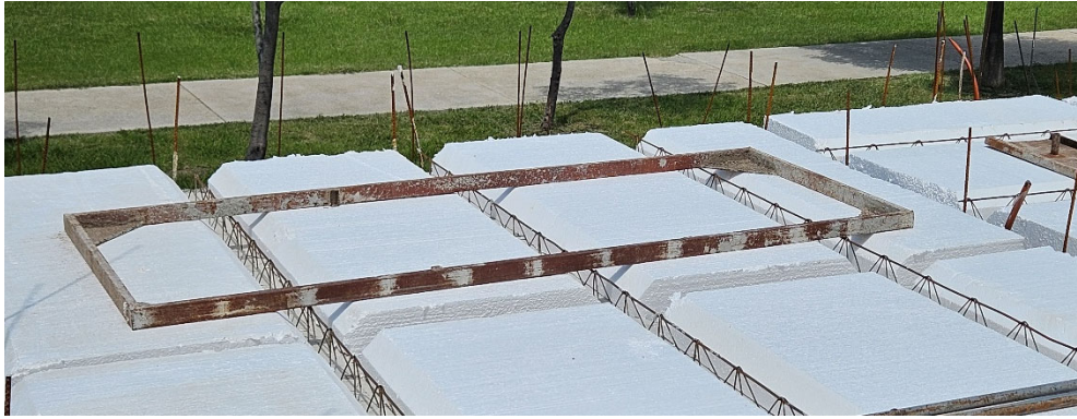
Imagen 63 Escantillón para puertas, Empresa 5. Fuente: Propia
