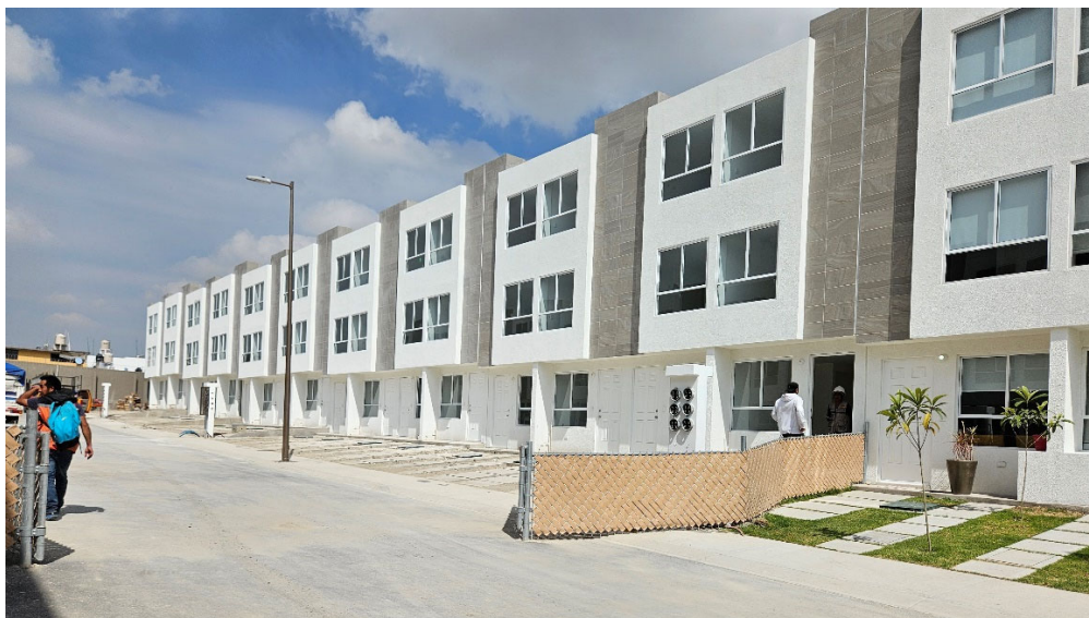
Imagen 34 Construcción de la obra 5. Fuente: Propia
