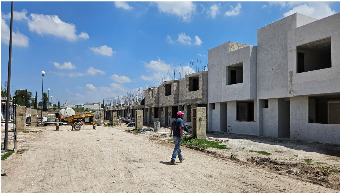
Imagen 35 Desarrollo de obra 6. Fuente: Propia
