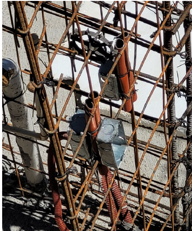
Imagen 45 Mangueras colocadas a la malla electrosoldada para asegurar la posición del registro eléctrico. Fuente: Propia
