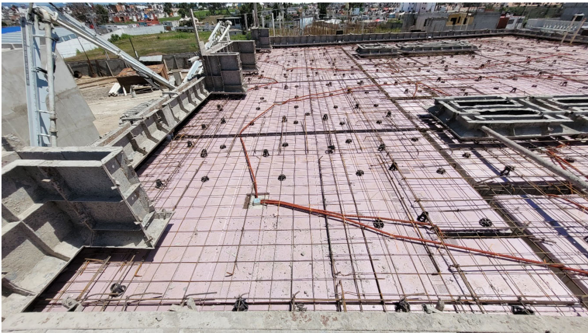
Imagen 62 Cimbra metálica para domos y remates de muros, Empresa 4. Fuente Propia
