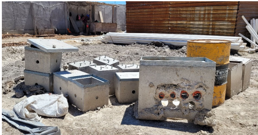
Imagen 57 Registros eléctricos prefabricados, Empresa 4. Fuente: Propia
