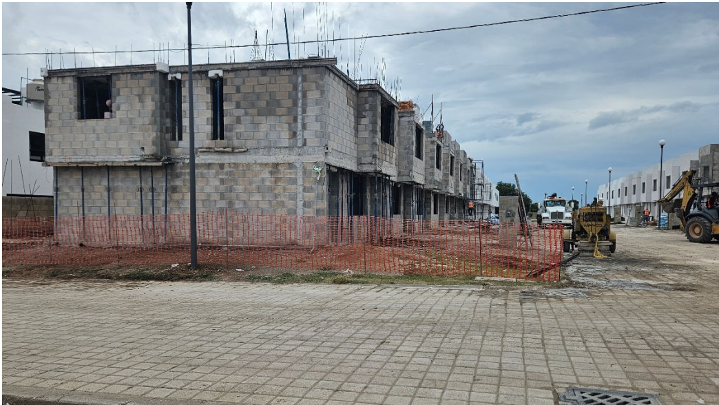
Imagen 79 Delimitación de la obra con el demás fraccionamiento. Empresa 5. Fuente: Propia
