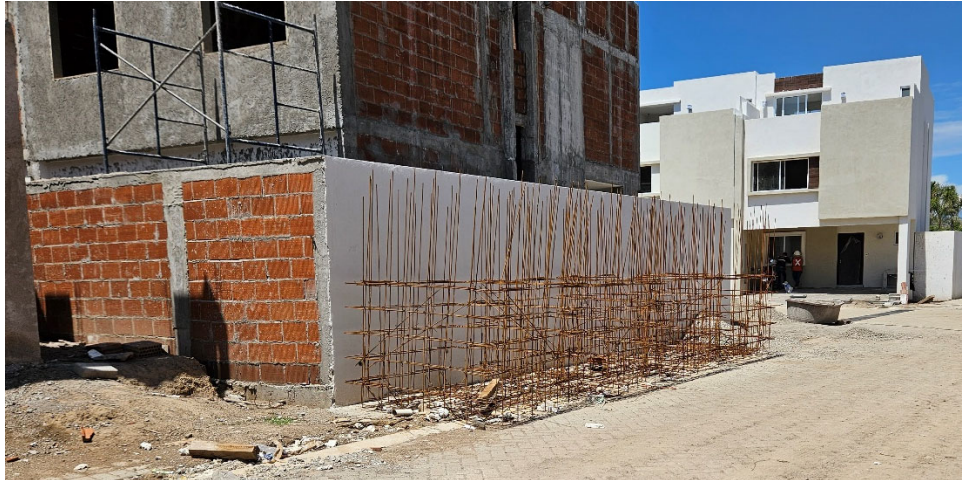
Imagen 42. Acero habilitado de cisternas de obra 1. Fuente: Propia
