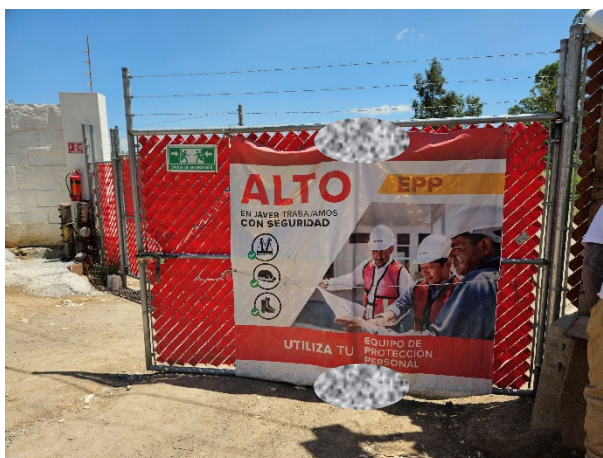
Imagen 69 Lona de Equipo de protección personal al acceso de la obra, Empresa 1. Fuente: propia
