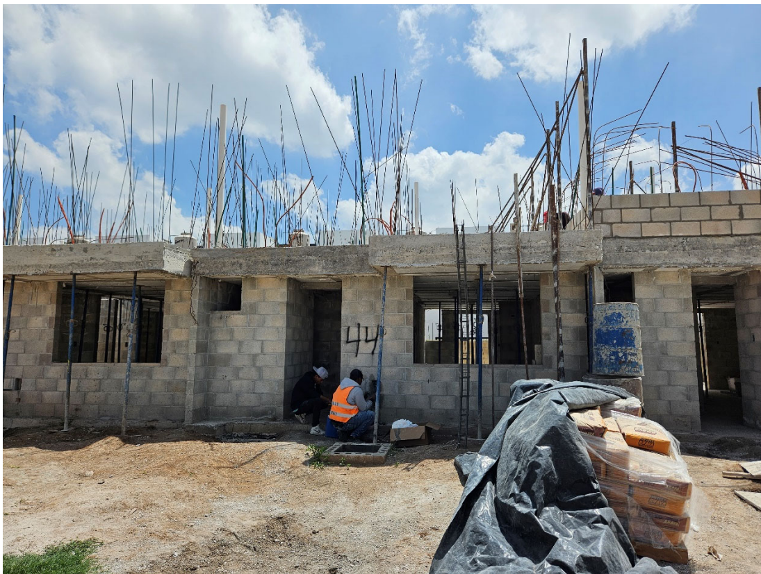
Imagen 29 Proceso constructivo autosoportante con castillos ahogados. Empresa 5. Fuente: Propia
