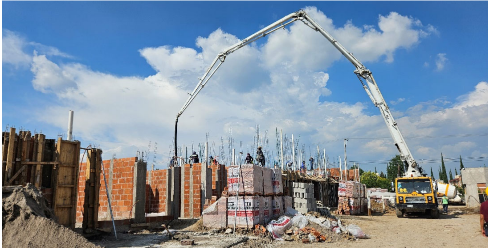
Imagen 32 Construcción de la obra 3. Fuente: Propia
