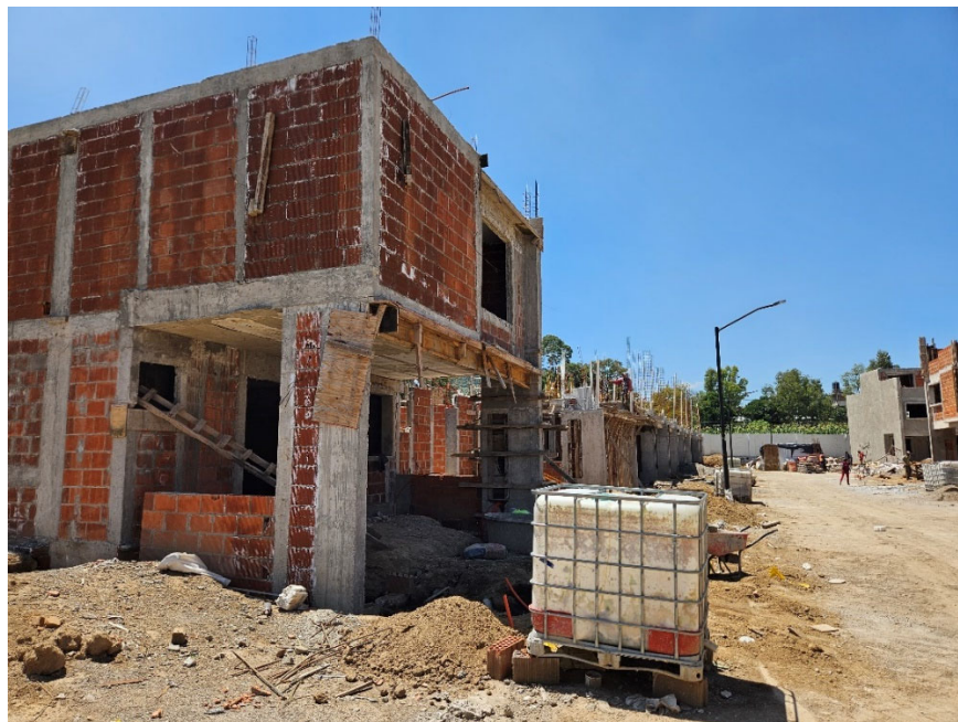
Imagen 27 Proceso tradicional de construcción Empresa 1. Fuente: Propia
