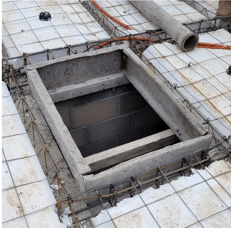
Imagen 66 Cimbra metálica para domos, Empresa 4. Fuente: Propia
