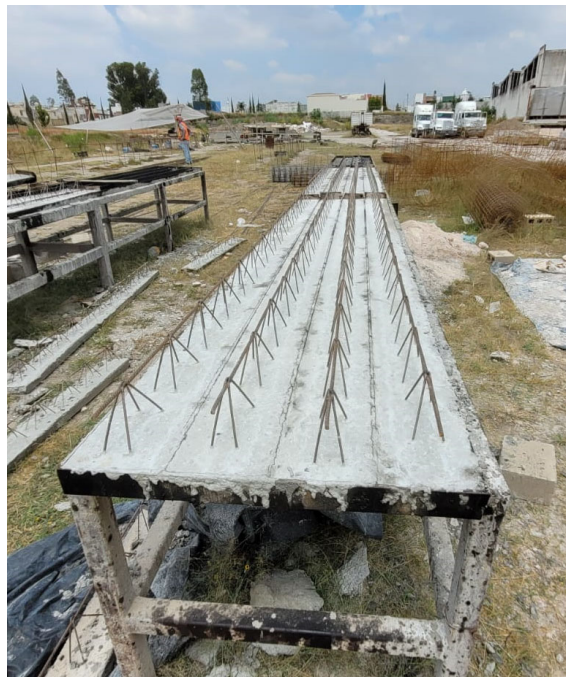
Imagen 67 Fabricación de viguetas en sitio. Empresa 5. Fuente Propia
