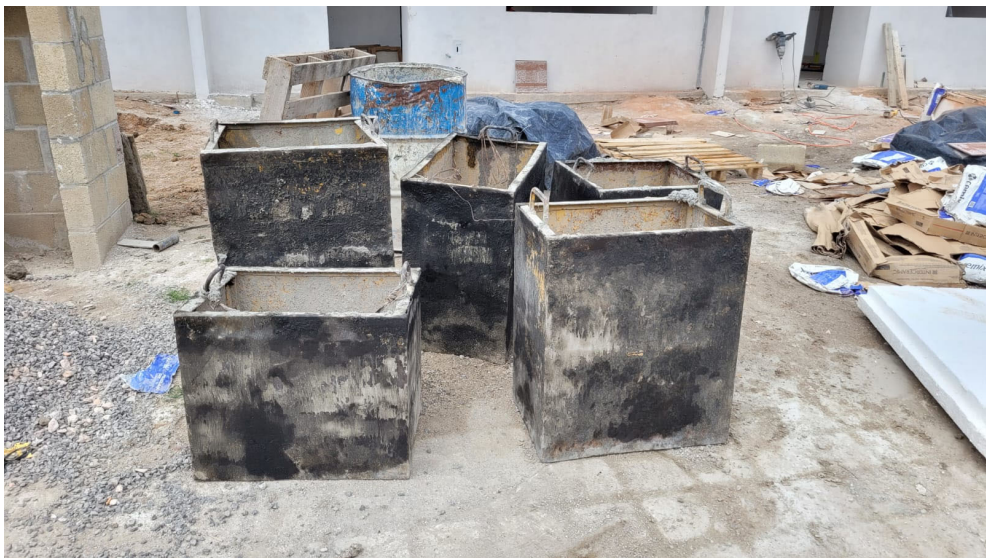
Imagen 64 Cimbra metálica para registros sanitarios, Empresa 5. Fuente Propia
