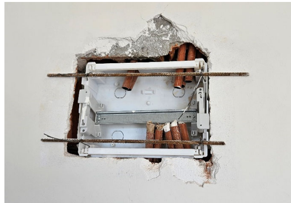
Imagen 43. Colocación de registro eléctrico dentro de la vivienda. Fuente: Propia
