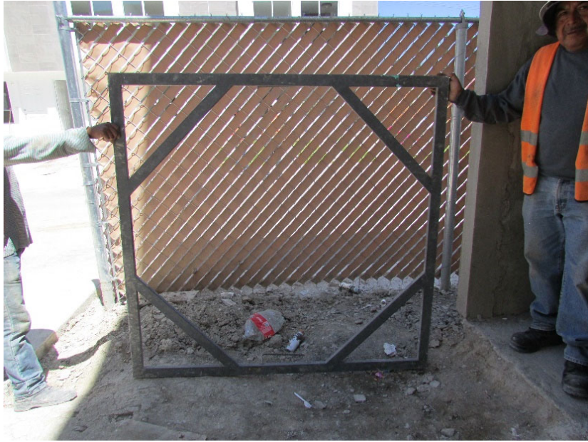
Imagen 59 Escantillón de ventana, Empresa 4. Fuente: Propia
