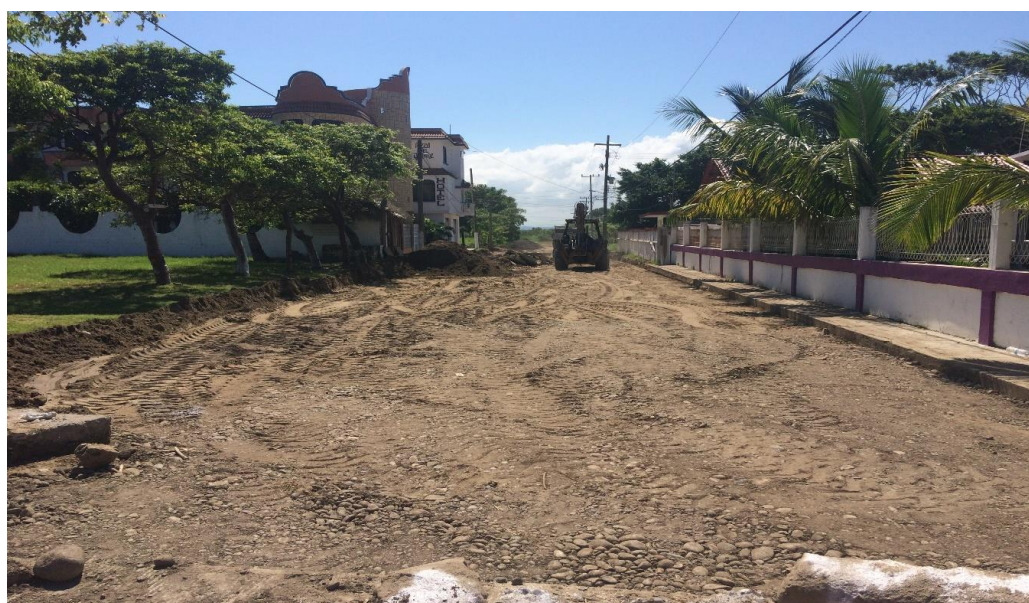
Figura 2.14. Se siguen pavimentando calles con el fin de mejorar la calidad de los servicios para el público en general. Fuente: Investigación de campo
