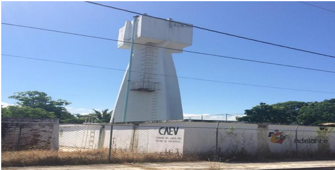
Figura 2.12. Sistema de bombeo de agua para el municipio de Tecolutla, Ver. Fuente. Investigación de campo.
