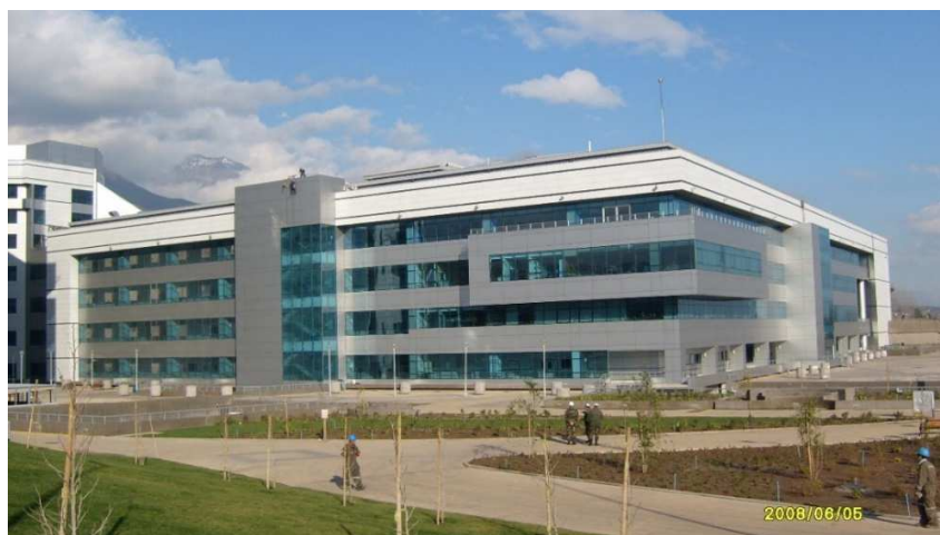
Fig. 3.23 Hospital militar de Santiago, Chile (el edificio principal tiene aisladores de base)
