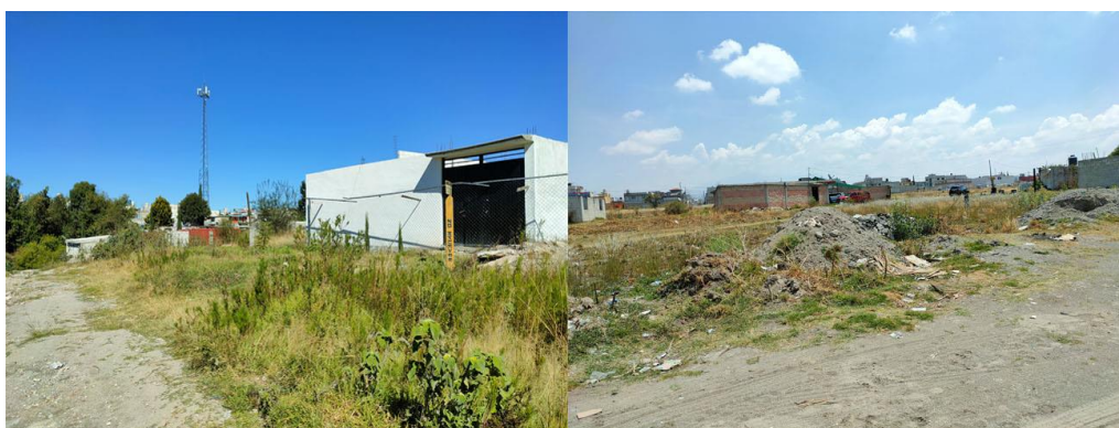
Figura 3. Construcciones sobre los ductos al suroeste del sector.
