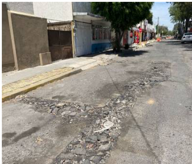
Figura 19. Trabajos de mantenimiento de tuberías y medidores en Jardines de San Manuel.
