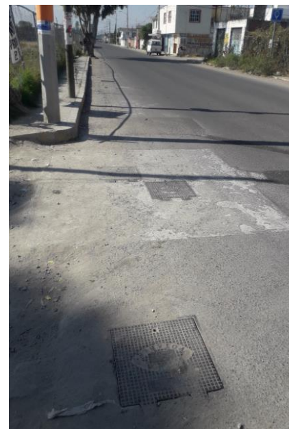
Foto 29: Toma de Agua potable. (Fuente: tesista).
