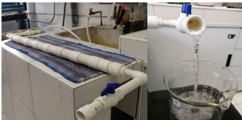
Figura 3.16. Sistema de purificación piloto instalado en toma de agua potable Extraído de: Cámara digital.
