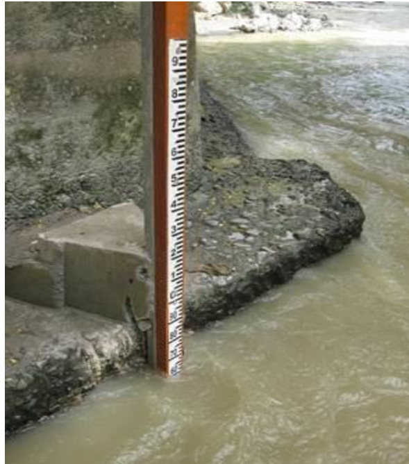
Ilustración 30 , Ejemplo de estación Hidrométrica, Fuente; CONAGUA, 2017.
