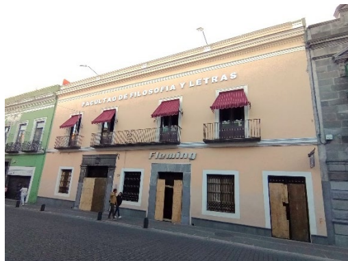
13. Edificio Flores Magón, Av. J. Palafox y M. no. 229, noviembre 2024. MMO.
