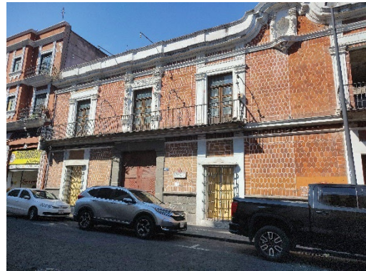
32. Edificio Ma. Fernanda, 5 Oriente no. 202-A, abril 2024. IYLR AOHS
