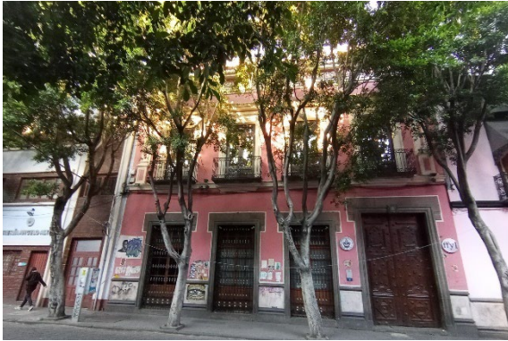
14. Edificio Sor Juana, 3 Oriente no. 214, noviembre 2024. MMO.
