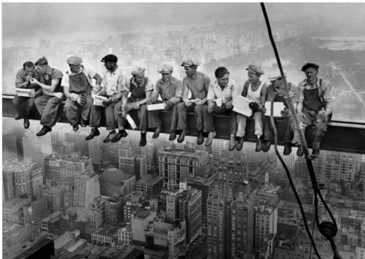
1932, Almuerzo en lo alto de un rascacielos (Lunch atop a Skyscraper) , once trabajadores en una viga durante la construcción de uno de los edificios que conforman el Rockefeller Center.
