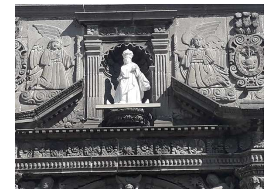
Detalle de ornamentación de piedra de villería sobre la Portada Lateral. Autor: Sergio Juárez
