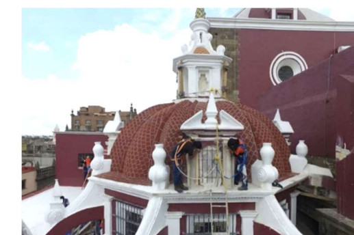
Acciones de Conservación de las cúpulas de la Catedral de Puebla tras el sismo del 20017. Fuente: La Jornada de Oriente. Foto: José Castañeres.
