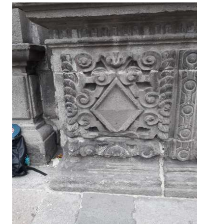
Manchas blancas en parte inferior izquierda de la Portada Principal del Templo de San Cristóbal. Autor: Sergio Juárez Saldivar.
