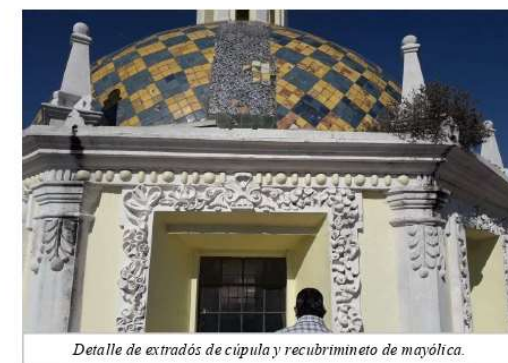
Detalle de extradós de cúpula y recubrimiento de mayólica.
