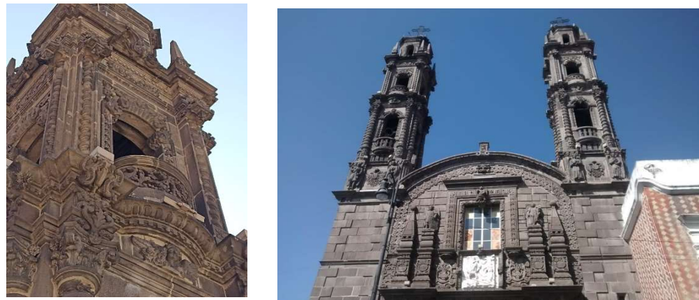
Vista Parcial y Vista General de las Torres en la Fachada Principal del Templo de San Cristóbal. Autor: Sergio Juárez Saldivar.
