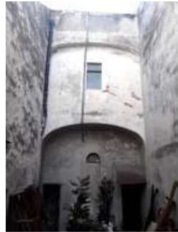
Fig.1 Muros del patio interior del templo de San Cristóbal. Autor: Sergio Juárez Saldivar.
