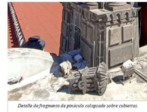
Detalle de fragmento de pináculo colapsado sobre cubiertas y cornisa.
