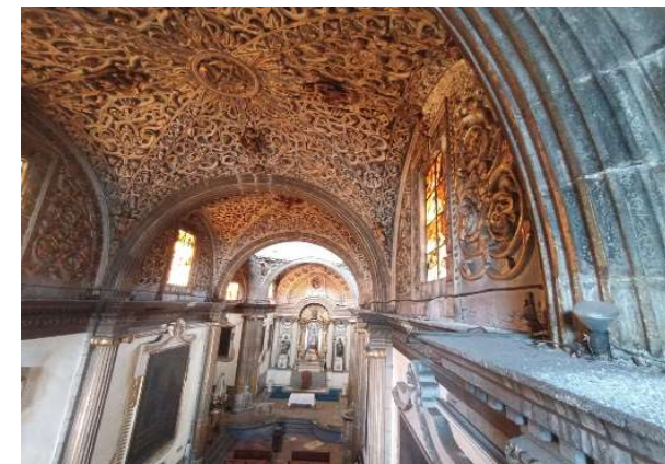
Vista interior del coro del Templo de San Cristóbal. Fuente: Sergio Juárez Saldivar, 03/07/2021
