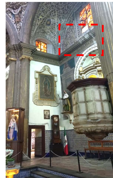
Presencia de fluorescencia sobre cornisas. Altura promedio desde nivel de piso 7.50 metros. Autor: Sergio Juárez, junio 2025
