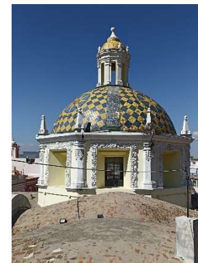
Vista General del Extradós de la Cúpula. Autor: Sergio Juárez Saldivar.
