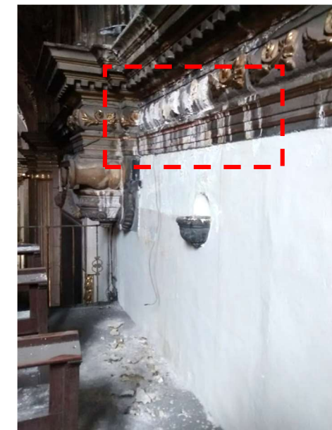
Presencia de fluorescencia sobre cornisas a nivel de Coro. Altura promedio desde nivel de coro 1.50 metros. Autor: Sergio Juárez, junio 2025
