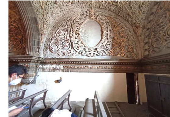
Vista General del acceso al Coro. Autor: Sergio Juárez Saldivar
