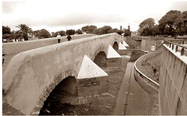
Conservación del Puente de 'Ovando' en Puebla Fuente: https://www.eluniversalpuebla.com.mx/que-hacer/leyendas-de-puebla-la-tragica-leyenda-del-puente-de-ovando/
