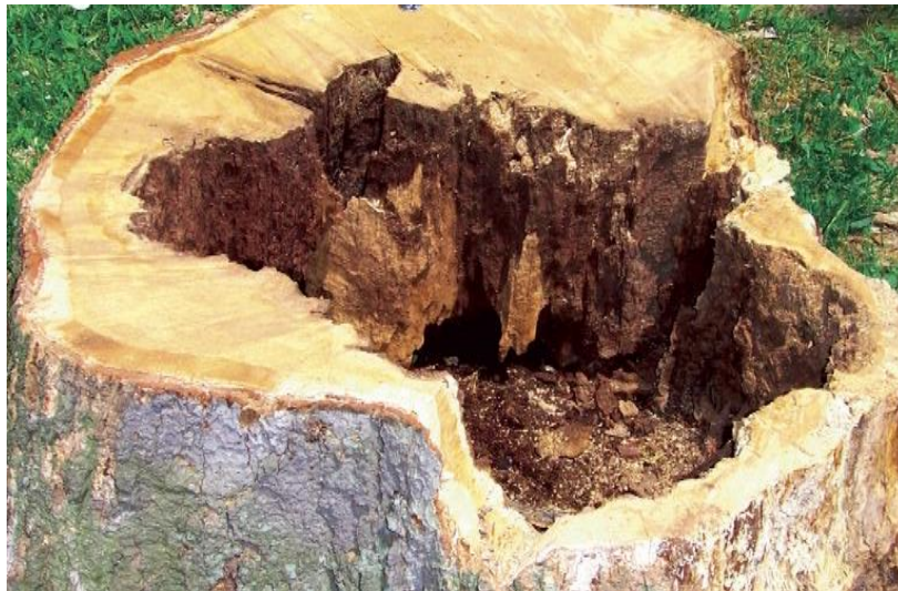
Figura 5. Pudrición café provoca un rápido deterioro en la resistencia de la madera infestada.
