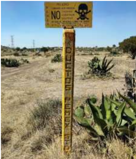
Ilustración 37: Señalética de delimitación de ductos de PEMEX
