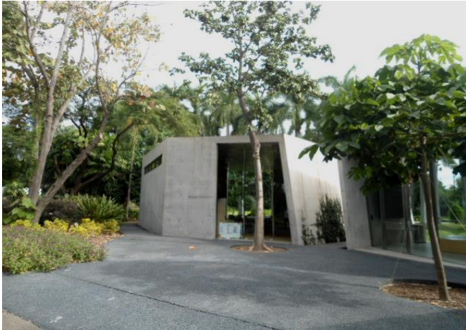
Figura 4.17. Edificaciones del conjunto educativo. Fuente: JCB, 27 de noviembre de 2013.
