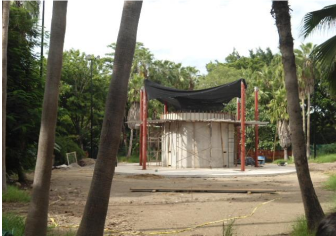
Figura 4.27. Pieza Encounter en proceso de construcción. Fuente: JCB, 27 de noviembre de 2013.
