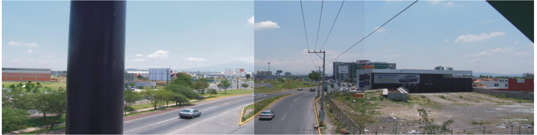
Fig. 24. Puente peatonal a la altura de Avenida Cúmulo de Virgo. Fuente: Sonia López, 2006
