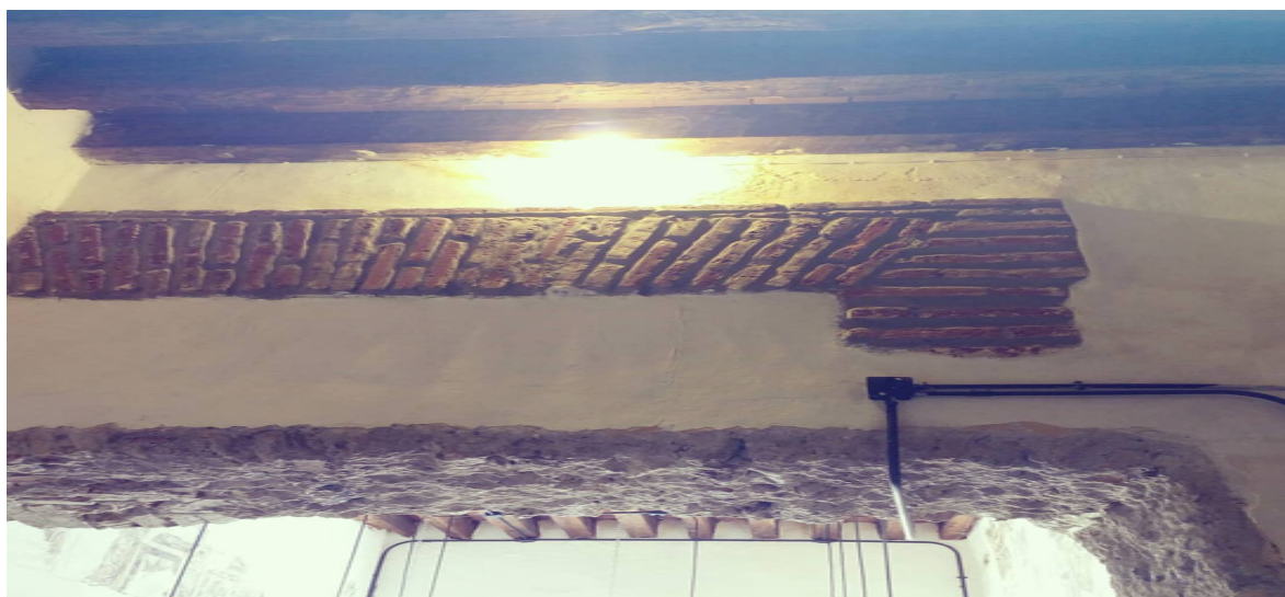
Figura 3. Arcos donde se muestran los materiales originales de construcción.
